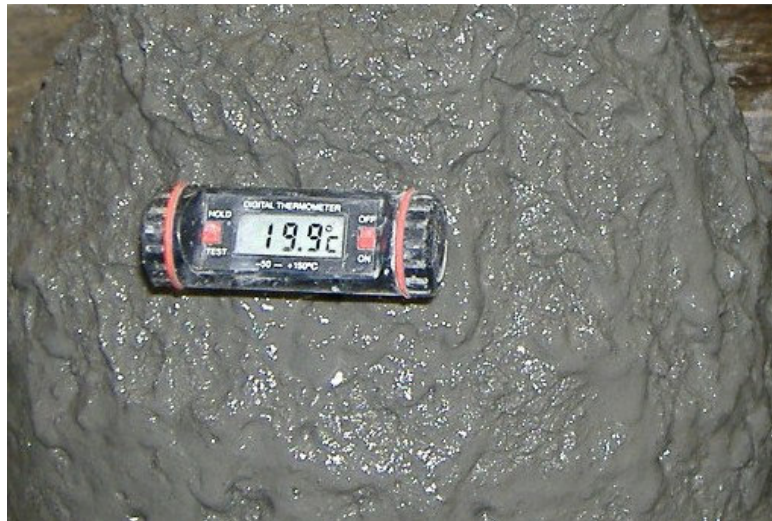
Figura 31 – Controle de temperatura do concreto
