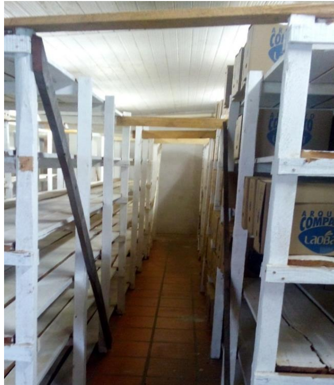
Figura 4 – Estantes de madeira apoiadas e sustentadas por ripas
