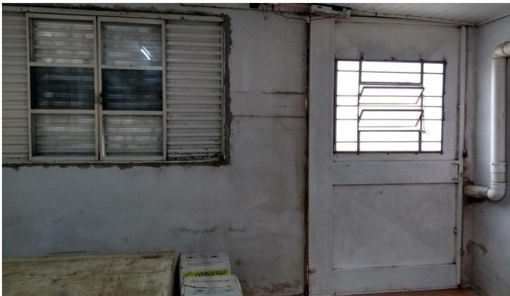
Figura 8 - Janelas da sala onde estão acondicionados os documentos
