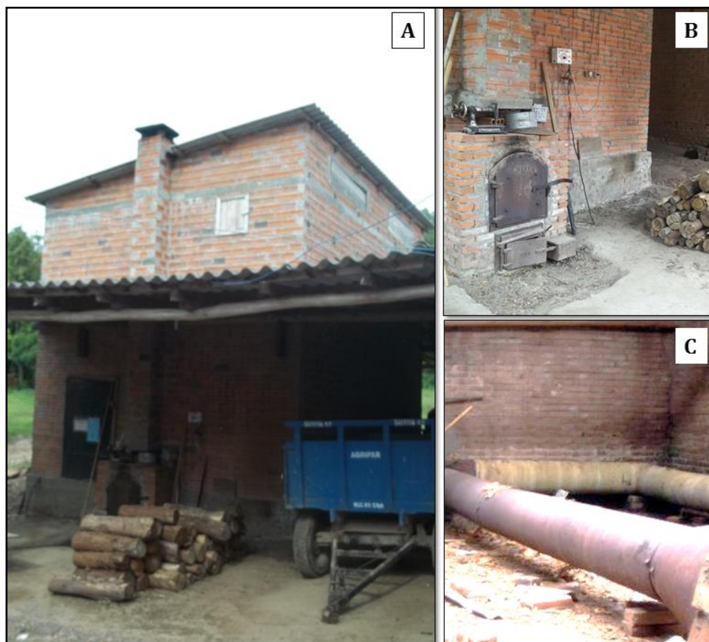
Figura 2 - A: Unidade convencional de cura de tabaco. B: Aspecto da fornalha, saída da chaminé e localização do controlador eletrônico de temperatura. C: Interior da unidade com tubulação de canos galvanizados.
