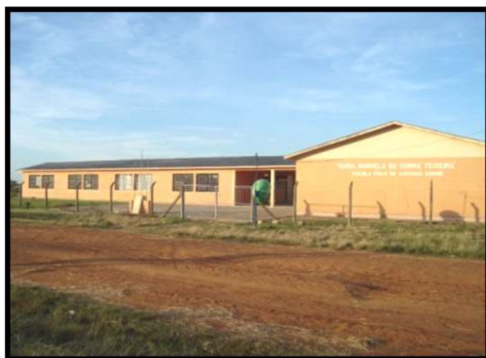
Figura 12 – Escola do Campo - EMEF Maria Manoela da Cunha Teixeira Fonte: Trabalho de Campo Elaborado pelo autor
