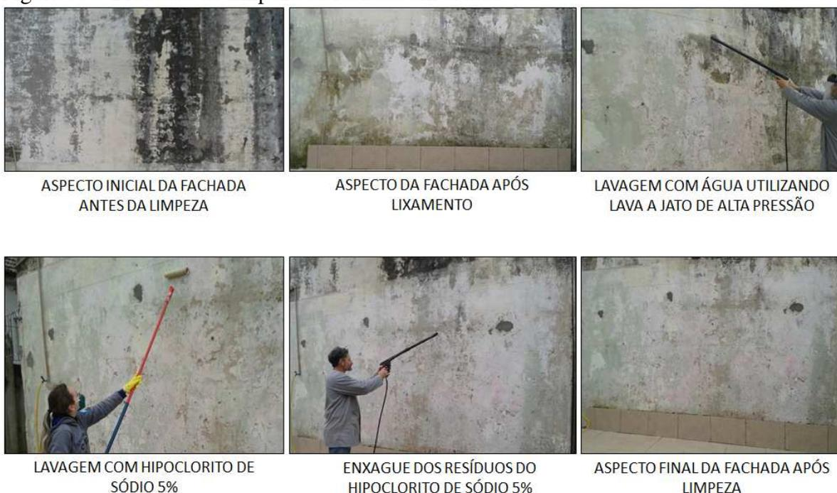
Observa-se que, depois de finalizada a limpeza, as manchas e os musgos foram completamente retirados. Sobre o revestimento de argamassa da fachada, grande parte da pintura continuou aderida, devendo-se retirá-la ou não para a aplicação dos revestimentos superficiais, seguindo as orientações do fabricante.
