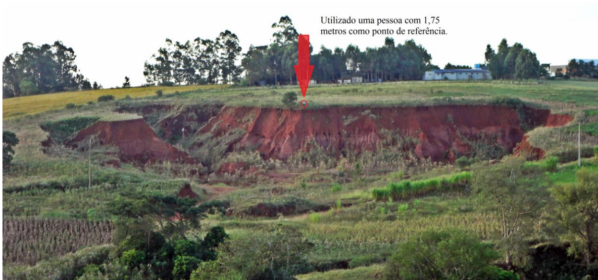
Figura 7: Vista do processo erosivo nº1. Fonte: arquivo pessoal
