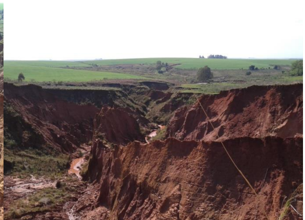
Figura 18b: Rachaduras e trincamentos Fonte: Arquivo pessoal
