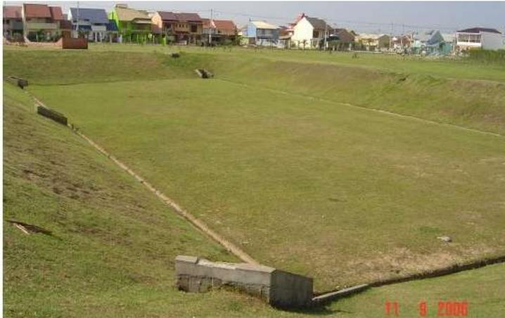
Figura 2 – Bacia de retenção em Porto Alegre-RS, que funciona como campo de futebol quando seca (Fonte: CONCREMAT, 2011)
