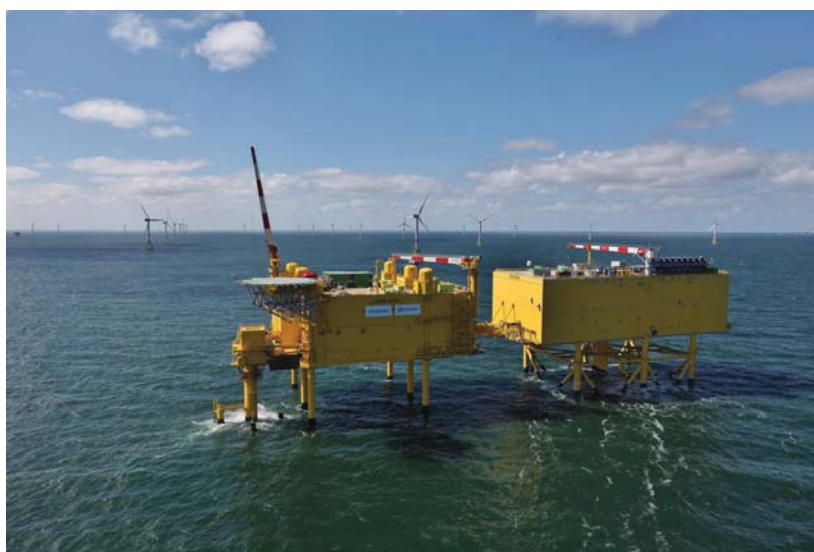
Figura 2.28 – Foto das estações conversoras Helwin 1 e 2 .
