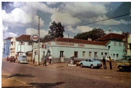
Figura 06: Avenida Brasil – posto Esso Boqueirão e Churrascaria Gobbi (Fonte: Thamires de Freitas)
