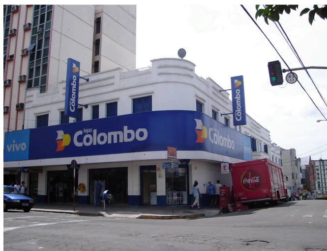
Figura 37 – Lojas Colombo – Rua do Acampamento esquina Rua Astrogildo de Azevedo - Santa Maria / RS 67
