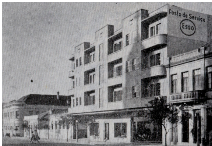
Figura 51 - Antigo Posto de Serviço Esso - Avenida Rio Branco, 842 e 854 84
