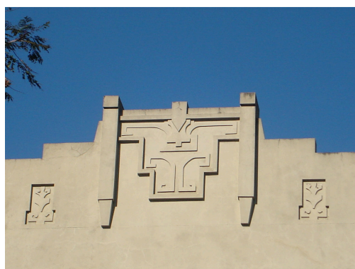
Figura 34 – Avenida Rio Branco – Santa Maria/ RS detalhe 48
