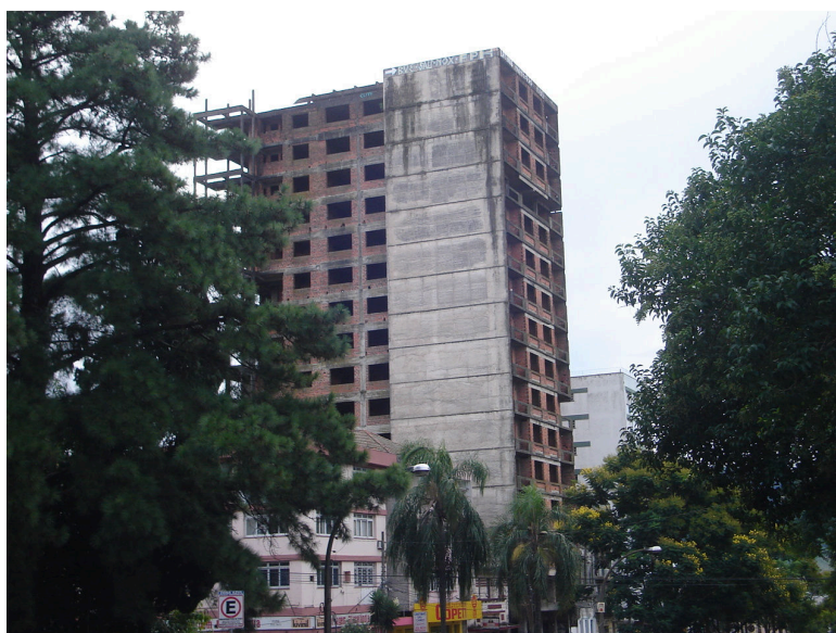
Figura 40 – Exemplo de marco – edifício inacabado – Av Rio Branco - Santa Maria / RS 70
