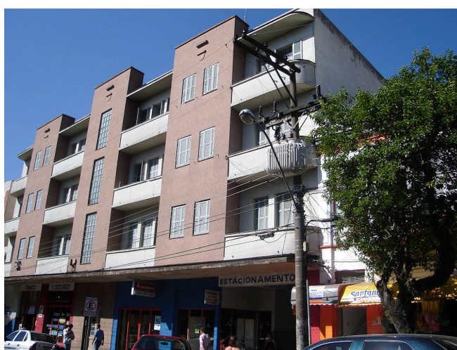
Figura 50 - Antigo Posto de Serviços Esso - Avenida Rio Branco, 842 e 854 83
