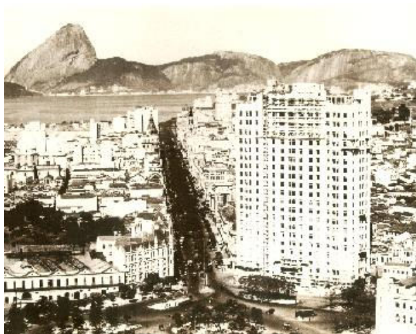
Figura 22 - Edifício A Noite (1929) – Joseph Gire e Elisário da Cunha Bahiana, Rio de Janeiro – em construção 29
