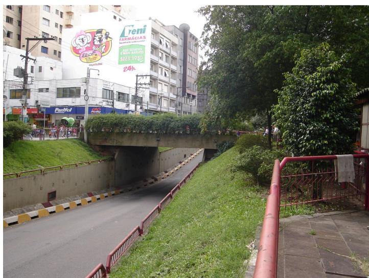
Figura 42 – Exemplos de ponto nodal - Viaduto Evandro Behr - Santa Maria / RS 72
