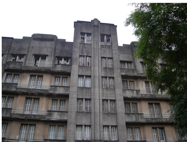
Figura 49 - Edifício Jantzen - Avenida Rio Branco esquina com a Rua Venâncio Aires 82
