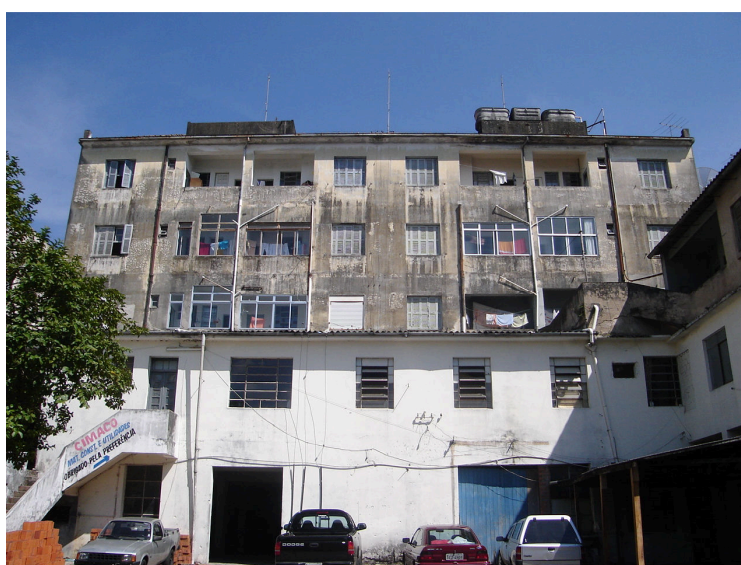
Figura 52 - Antigo Posto de Serviços Esso - Avenida Rio Branco, 842 e 854 85
