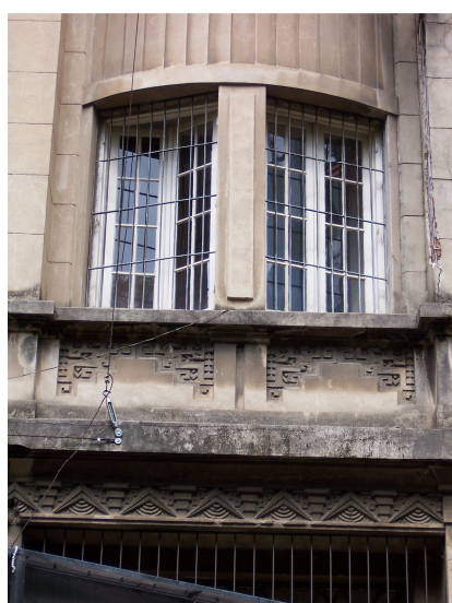
Figura 3 – Edifício Imperial (detalhe), Porto Alegre 8
