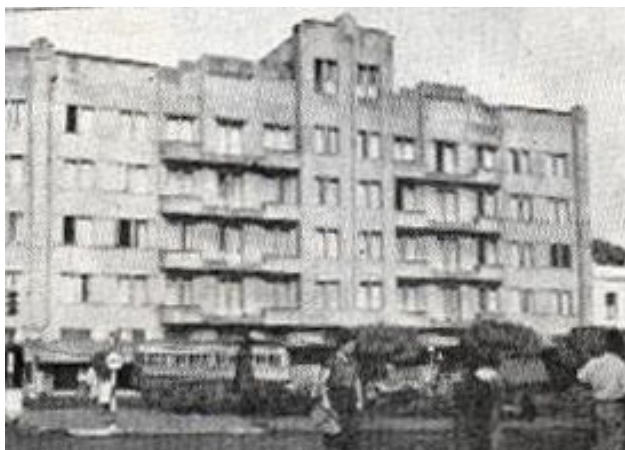
Figura 48 - Edifício Jantzen (1940) - Avenida Rio Branco esquina com a Rua Venâncio Aires 81
