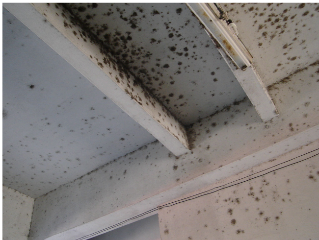
Figura 53 - Antigo Posto de Serviços Esso - Avenida Rio Branco, 842 e 854 86
