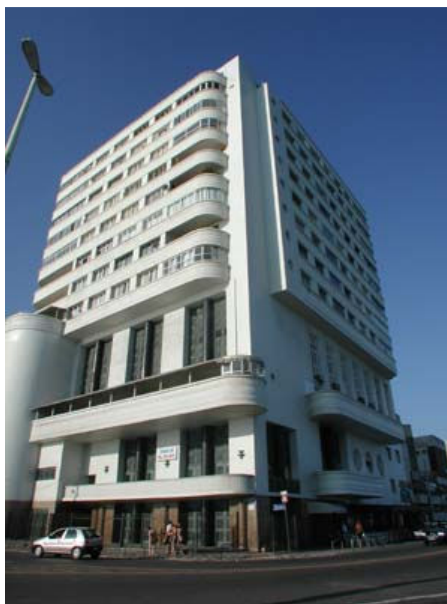
Figura 23 - Edifício Oceania – Freire & Sodré (décadas de 30 e 40), Salvador 30
