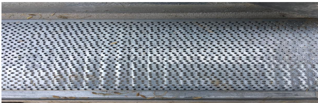
Figura 2 - Pisos perfurados dos silos secadores.
