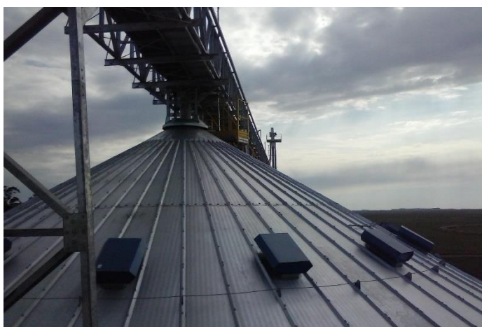
Figura 3 - Detalhamento dos respiros de exaustão.
