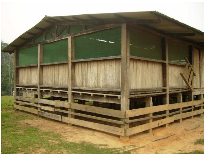
Figura 22: Galpão para pré-secagem desenvolvido pela EMBRAPA para o controle de Aflatoxinas.
