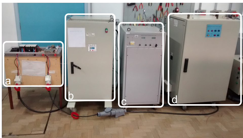
Figura C.1 – Visão geral do protótipo: (a) indutores para ensaios de variação paramétrica, (b) inversor e filtro LCL, (c) fonte de alimentação CC e (d) VARIAC para conexão com a rede elétrica.
