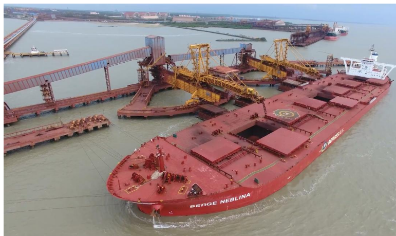
Figura 1 – Terminal marítimo de Ponta da Madeira - Píer IV
