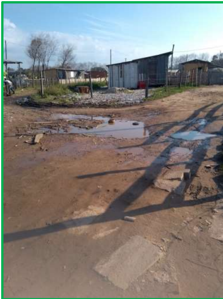
Figura 9 - Fotografia de área com ocupação irregular, apresenta alagamento e rua sem pavimentação.
