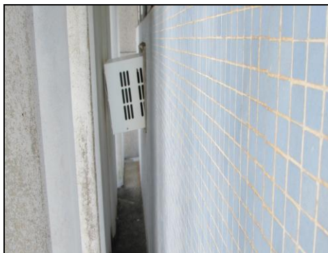
Figura 46 - Espaço parede e brises-soleil
