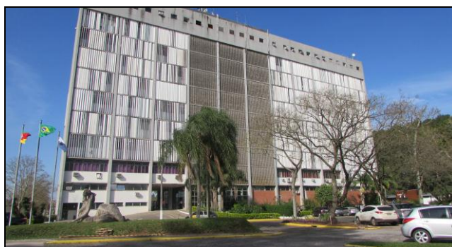
Figura 2 - Prédio da Adm. Central, fachada Oeste – 2015
