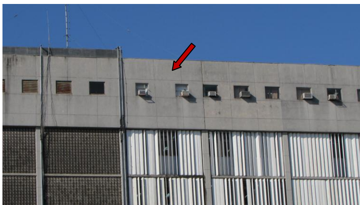
Figura 32 - Detalhe fachada Oeste – platibanda
