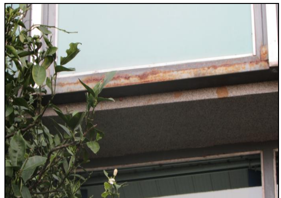
Figura 43 - Detalhes fachada Leste: esquadria metálica
