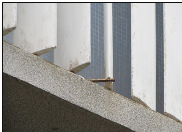
Figura 49 - Detalhe brises-soleil
