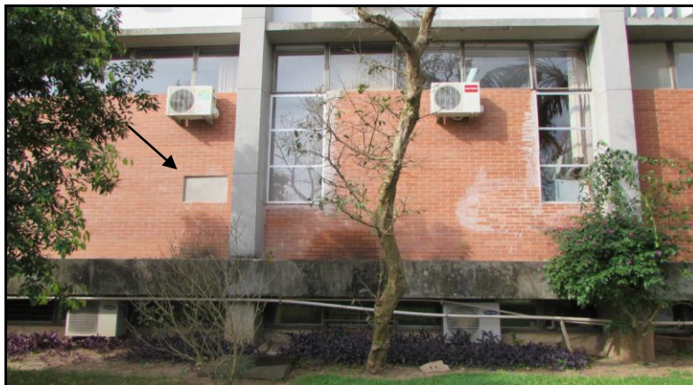
Figura 50 - Detalhe fachada Oeste
