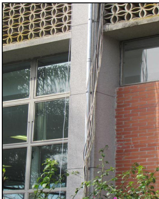
Figura 54 - Detalhe fachada Oeste
