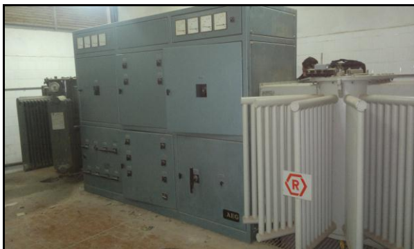
Figura 59 - Transformadores subestação
