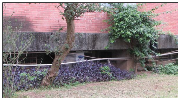
Figura 28 - Detalhes das canalizações da fachada oeste
