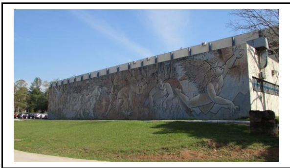
Figura 7 – Paineis fachada do CAL
