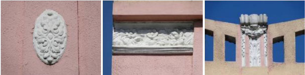
Figura 105 – Adorno das pilastras (esquerda), friso decorado (centro) e pilarete da platibanda
