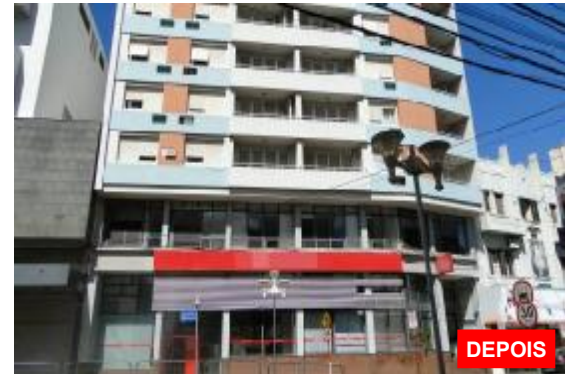
Figura 26 – Construção atual Fonte – Arquivo do autor, 2012
