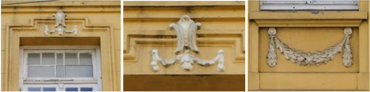
Figura 63 – Ornamentos das esquadrias (esquerda e centro) e festão abaixo das janelas do térreo (direita)
