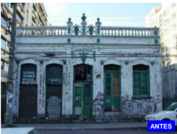
Figura 13 – Edificação localizada na Rua Pinheiro Machado, s/nº Fonte – PMSM/SEPLAN, 2003
