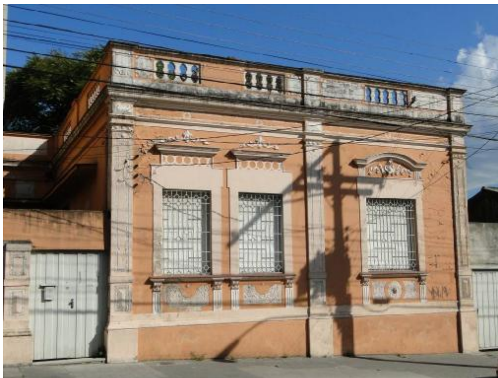
Figura 131 – Antiga Residência Manoel Ribas
