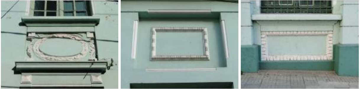
Figura 51 – Ornamentos de entresijos (esquerda e centro) e moldura abaixo do peitoril, nas janelas do térreo, pela Rua Floriano Peixoto (direita)
