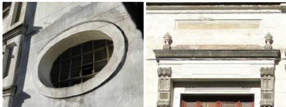
Figura 76 – Janela oval encontrada nas laterais (esquerda) e sobrevergas das portas-janelas (direita)
