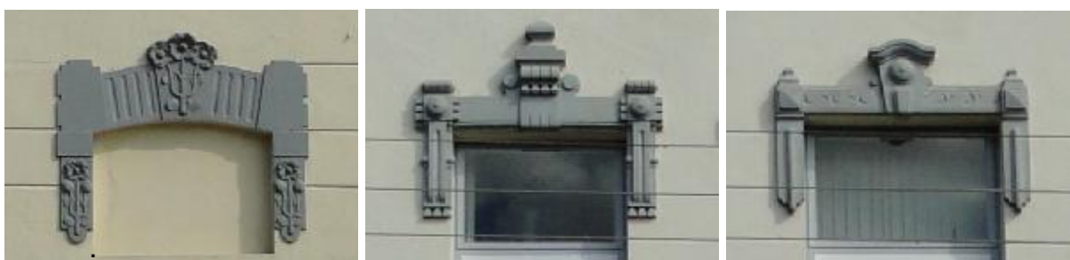
Figura 145 – Sobreverga do andar térreo (esquerda) e sobrevergas do andar superior (centro/direita)
