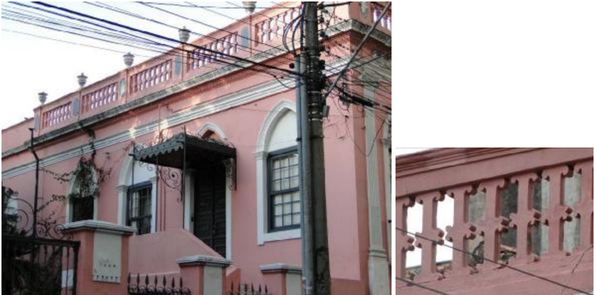
Figura 90 – Fachada lateral esquerda e balaústres da platibanda
