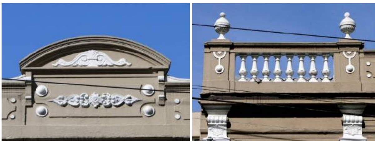
Figura 129 – Frontão arqueado (esquerda) e parte da platibanda vazada por balaústres e encimada por compoteiras (direita)
