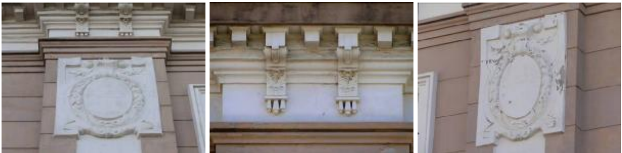
Figura 61 – Detalhes das pilastras ornadas com medalhões chapados
