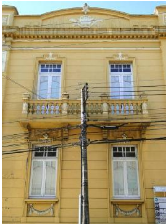
Figura 57 – Foto parcial da fachada pela Rua dos Andradas
