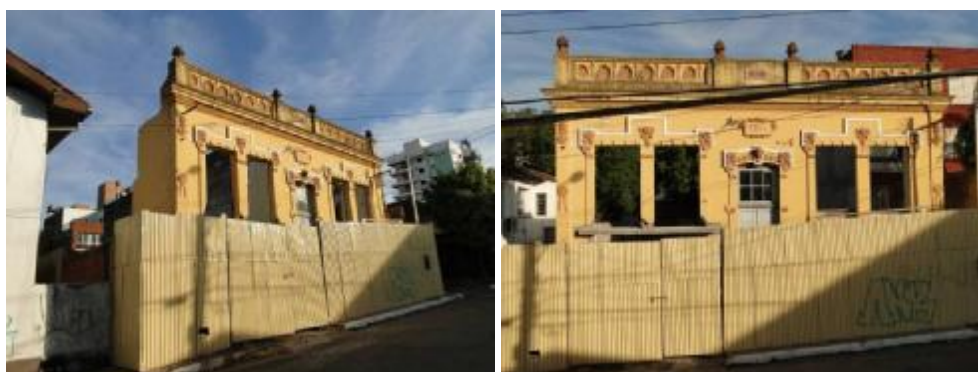
Figura 138 – Fachada após demolição
