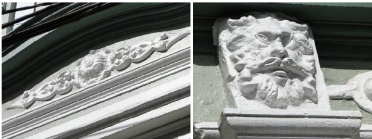
Figura 142 – Ornato abaixo da cornija movimentada (esquerda) e mascarão das pilastras (direita)
