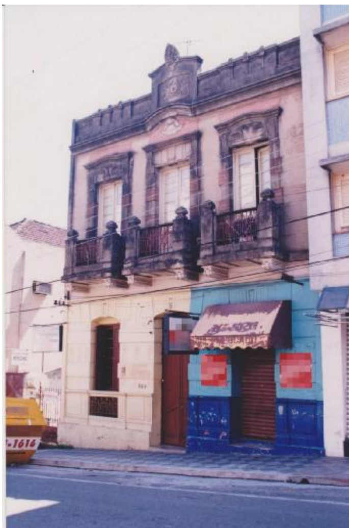
Figura 157 – Fachada do imóvel antes do aumento de vão no térreo Fonte – Arquivo Histórico de Santa Maria (Foto de BLAYA PEREZ, Carlos. 1998)
