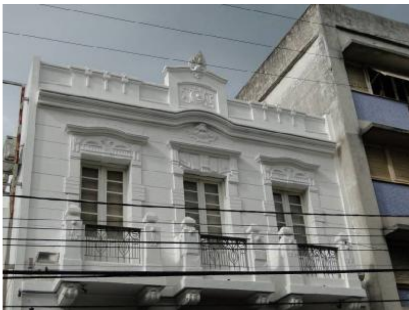
Figura 154 – Portas-janelas e balcões localizados no andar superior
