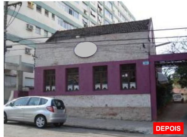
Figura 08 – Descaracterização de imóvel, retirada de elementos ornamentais Fonte – Arquivo do autor, 2010
