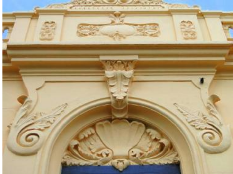
Figura 118 – Ornamentação sobre o portão de entrada
