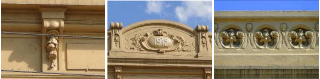
Figura 81 – Ornato em forma de flores pendentes entre a cimalha e a cornija (esquerda), frontão arqueado, ostentando cartela com o ano de construção do imóvel (centro) e ornamentação da platibanda (direita)
