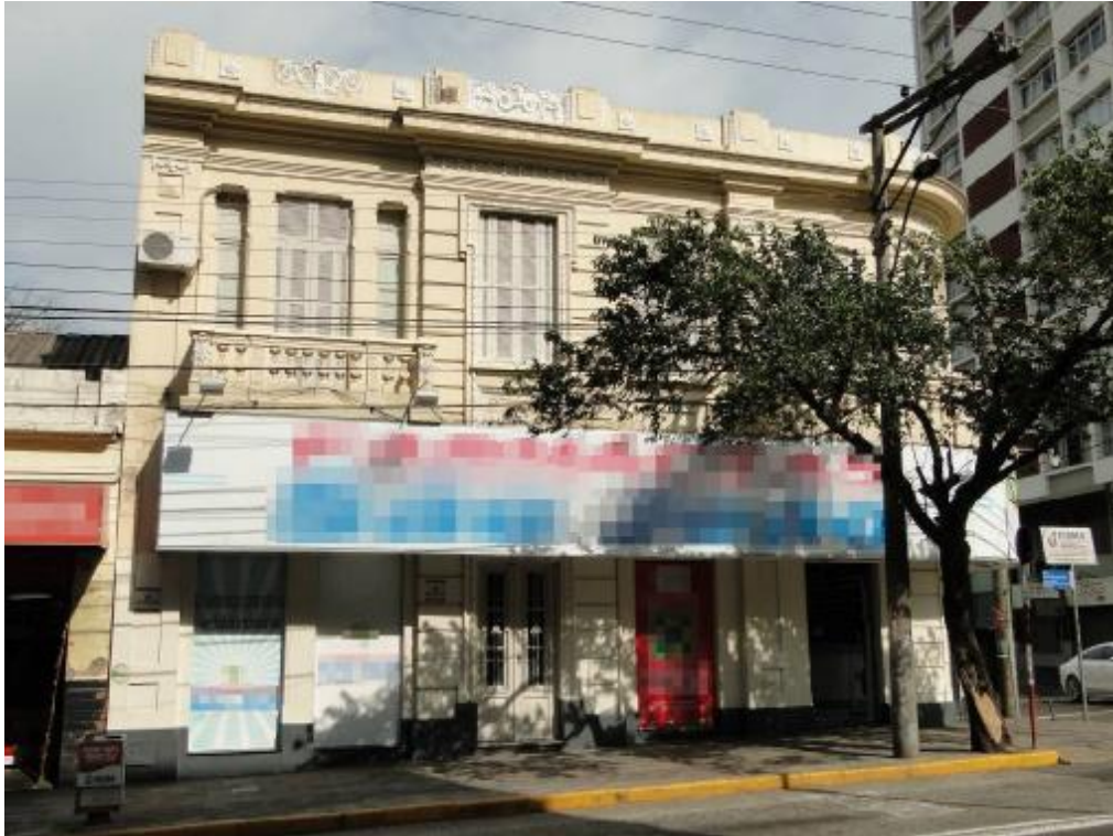
Figura 39 – Fachada pela Rua do Acampamento
