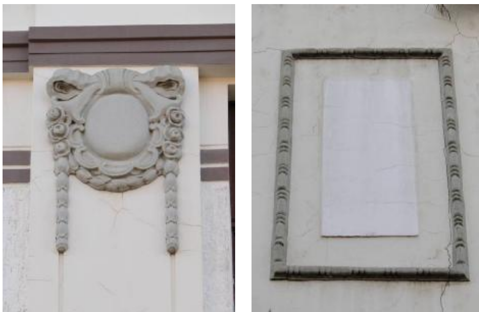
Figura 113 – Medalhão chapado localizado no topo das pilastras (esquerda) e moldura de entrepisos encontrada na fachada pela Rua Ernesto Beck (direita)
