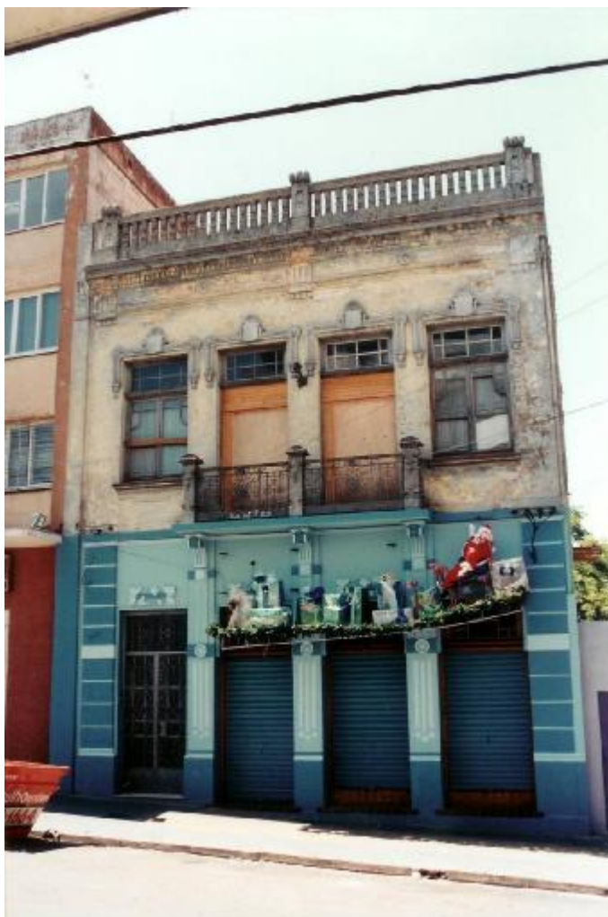
Figura 164 – Foto antiga do imóvel
