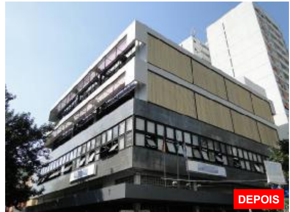
Figura 24 – Construção atual Fonte – Arquivo do autor, 2012
