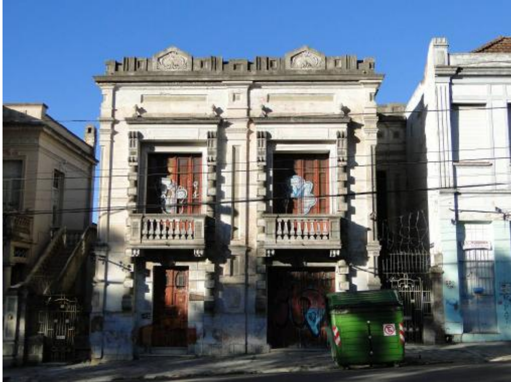
Figura 74 – Antiga Residência Fernandez
