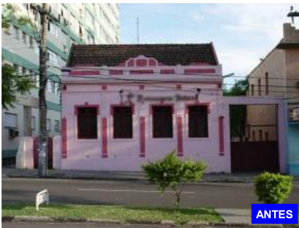
Figura 07 – Edificação localizada na Av. Presidente Vargas, nº 2081 Fonte – PMSM/SEPLAN, 2003
