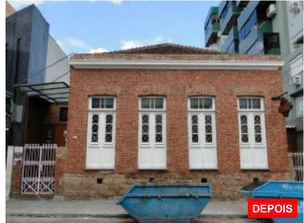
Figura 10 – Descaracterização do imóvel, retirada de elementos ornamentais Fonte – Arquivo do autor, 2011
