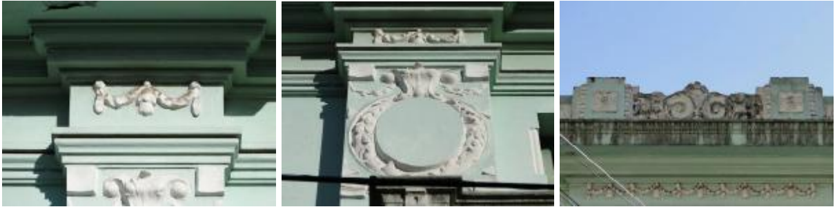
Figura 49 – Adorno em feitio de laço na conjunção do friso com a pilastra (esquerda), medalhão chapado (centro), rendilhado abaixo da cornija ressaltada e, acima dela, ornatos com volutas (direita)
