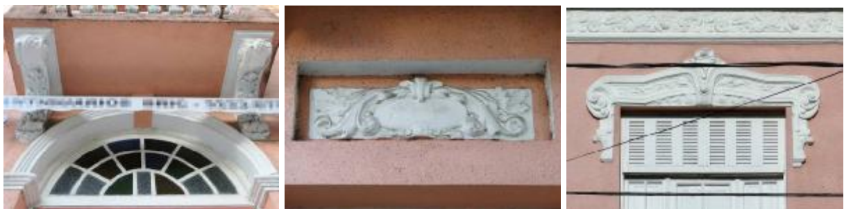
Figura 102 – Bandeira em leque das portas laterais (esquerda), ornato acima da porta intermediária (centro) e sobreverga e bandeira venezianada das portas-janelas do andar superior (à direita)
