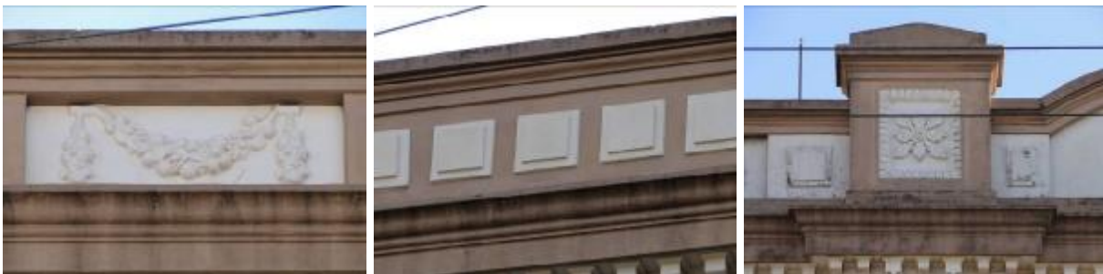
Figura 65 – Ornamentos da platibanda
