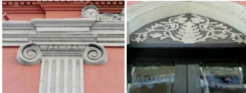
Figura 87 – Capitel jônico das pilastras (esquerda) e bandeira ornada com arabescos (direita)
