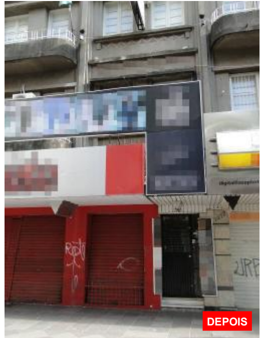
Figura 22 – Construção atual Fonte – Arquivo do autor, 2012
