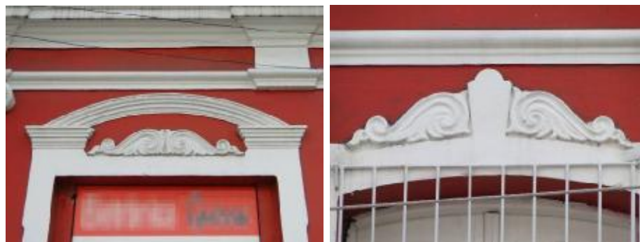
Figura 167 – Sobreverga do térreo (esquerda) e sobreverga do andar superior (direita)
