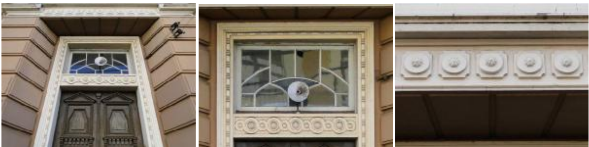
Figura 55 – Detalhes da porta de entrada
