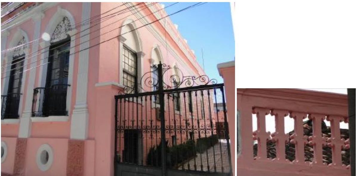
Figura 91 – Fachada lateral direita e balaústres da platibanda
