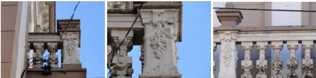
Figura 64 – Detalhes dos balcões balaustrados
