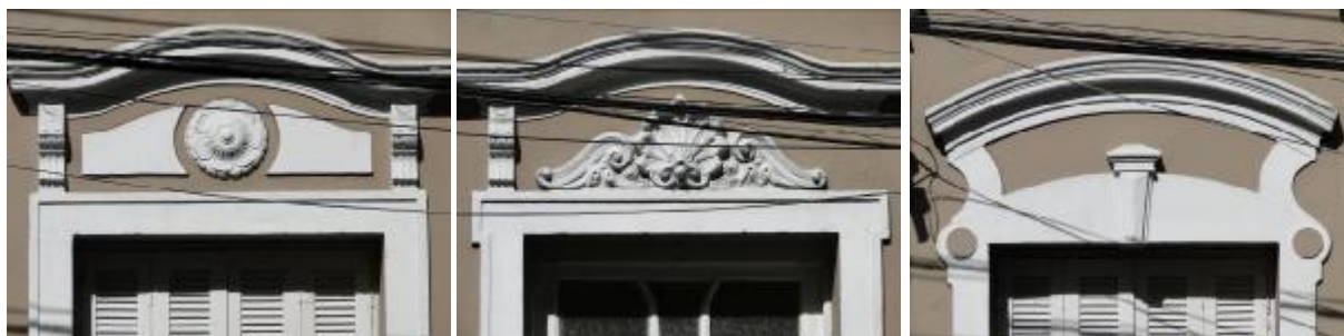
Figura 128 – Sobrevergas das janelas (esquerda e direita) e sobreverga da porta (centro)
