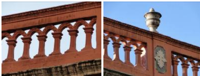
Figura 89 – Detalhe da platibanda frontal e de um dos seus pilaretes, sustentando compoteira
