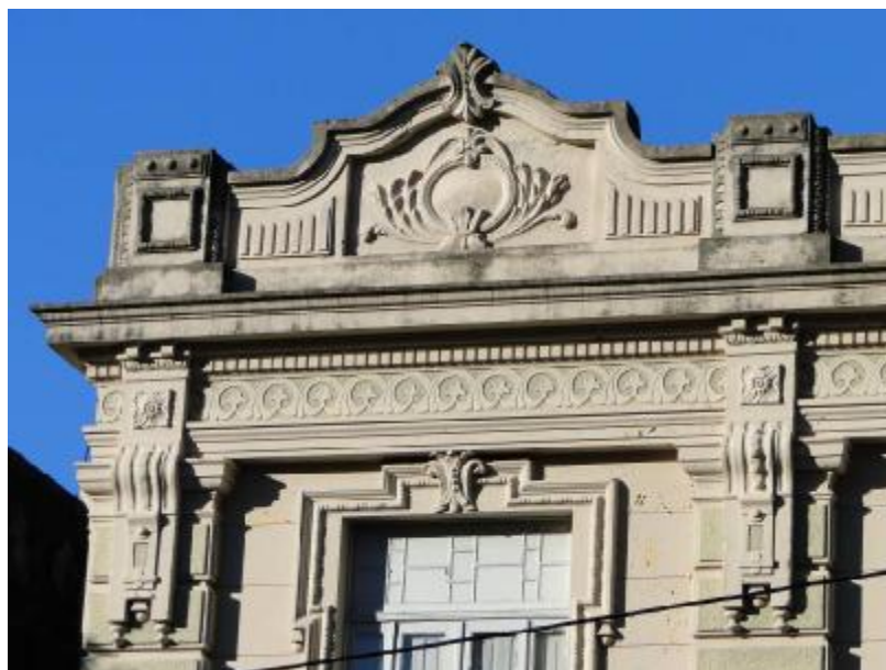
Figura 72 – Foto parcial do coroamento ornamentado
