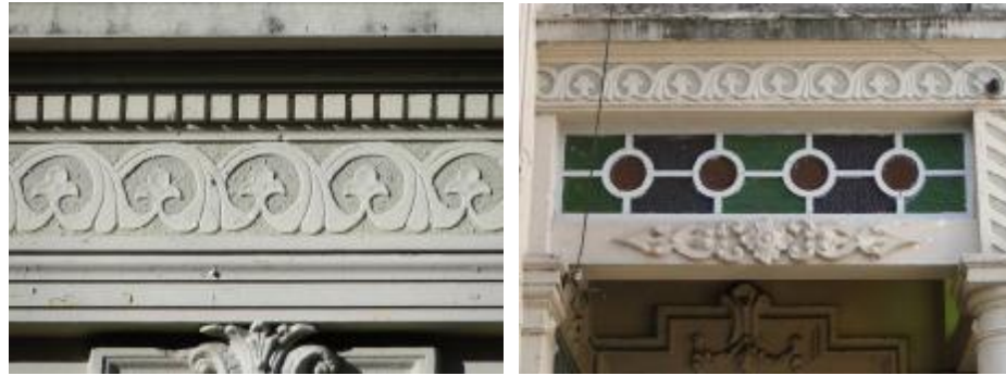
Figura 71 – Friso rendilhado encontrado na platibanda (esquerda) e no acesso coberto do térreo
