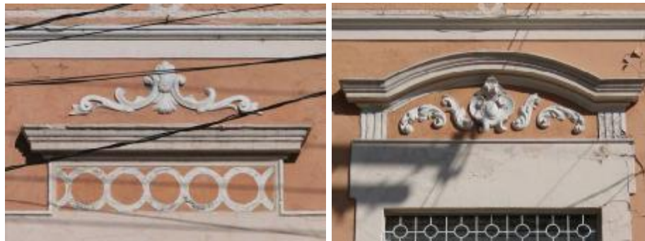
Figura 132 – Cimalhas das janelas frontais
