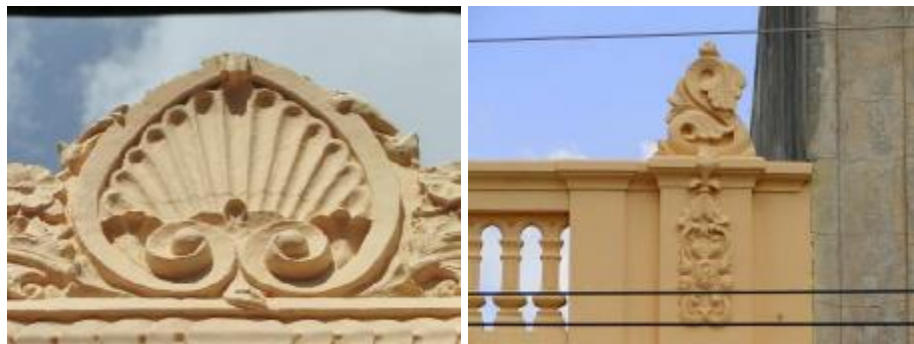
Figura 121 – Acrotérios da platibanda
