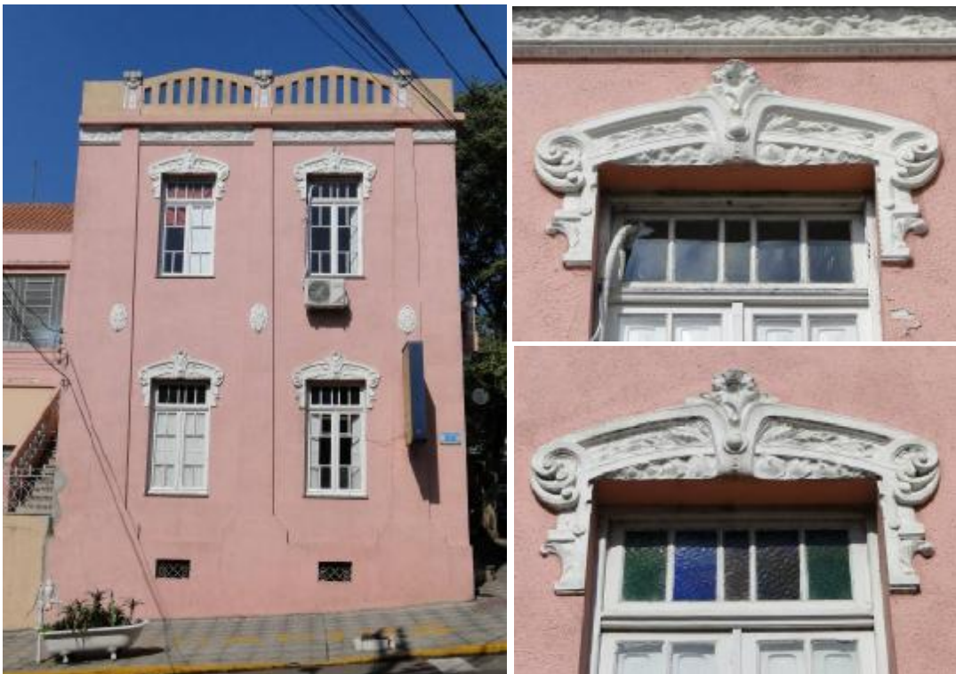
Figura 104 – Fachada voltada para a Rua Vale Machado e fotos das sobrevergas das janelas
