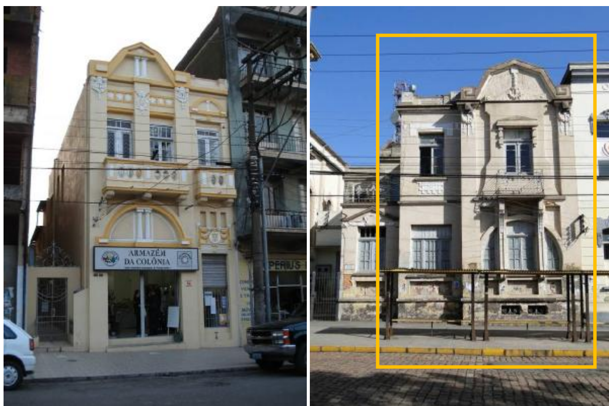
Figura 148 – Imóvel na Avenida Rio Branco, nº 455 (esquerda) em comparação com parte da antiga Residência Mário Machado (direita)
