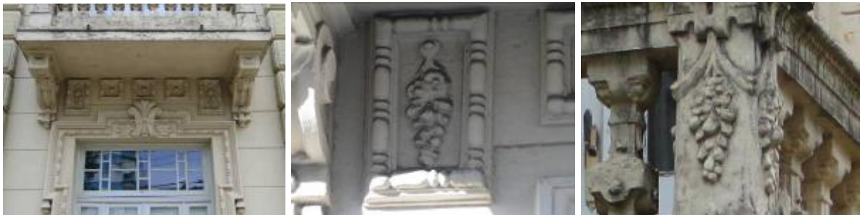
Figura 69 – Bandeira de uma das janelas do térreo e sua sobreverga decorada (esquerda), ornamento em forma de cacho de frutas e flores acima da sobreverga (centro) e o mesmo ornamento encontrado nos pilaretes dos balcões (direita)
