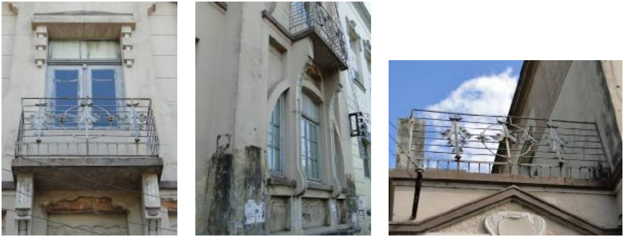
Figura 108 – Balcão sobre janela tripartida (esquerda), pilares misulados (centro) e guarda-corpo do segundo andar (direita)
