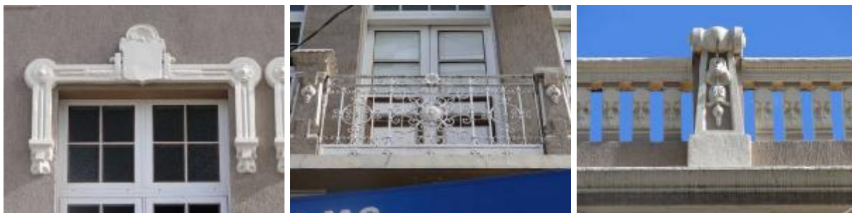
Figura 163 – Sobreverga das esquadrias do andar superior (esquerda), balcão de ferro (centro) e detalhe da platibanda
