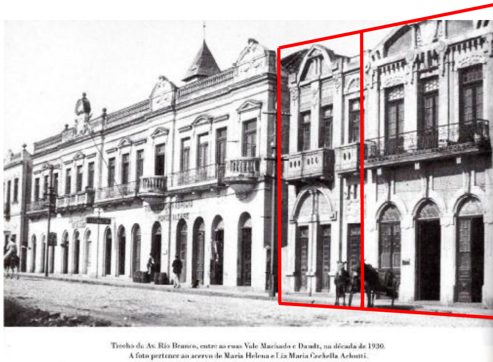
Figura 151 – Imóvel em sua totalidade na década de 30
