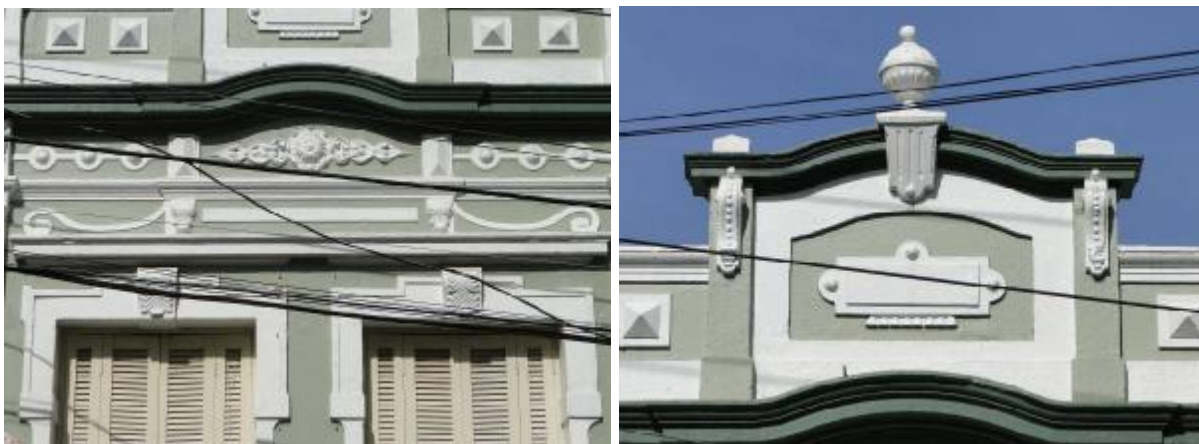
Figura 141 – Sobrevergas das janelas e friso ornado (esquerda) e frontão encimado por compoteira (direita)
