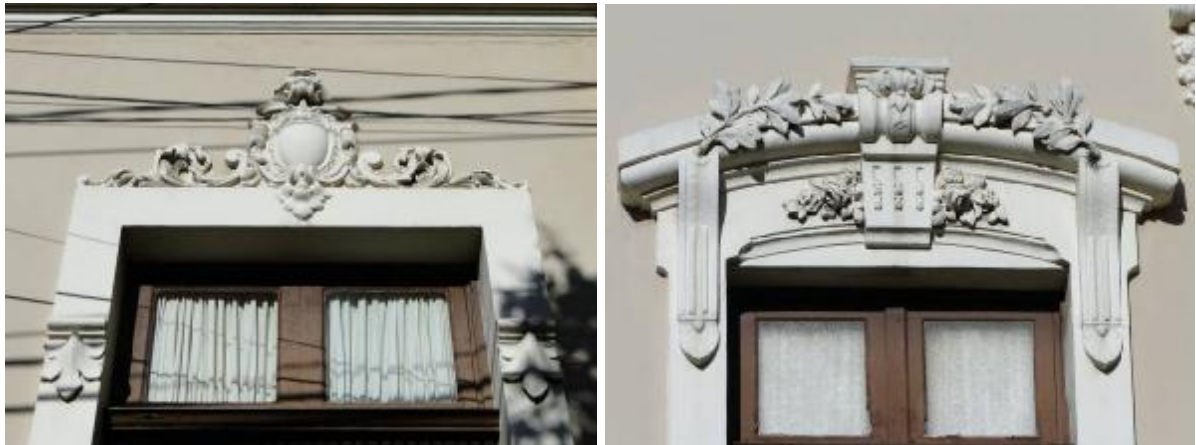
Figura 96 – Sobreverga das janelas (esquerda) e sobreverga das portas-janelas (direita)
