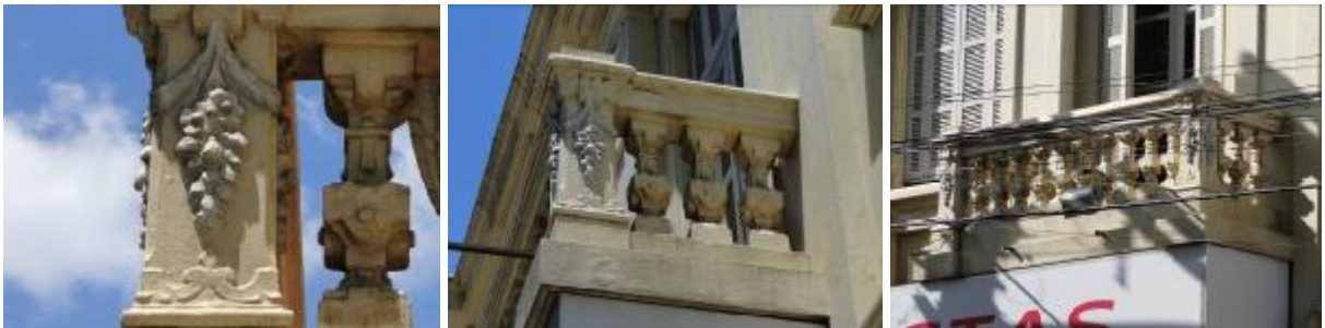
Figura 42 – Balcão constituído de balaústres e adornado por cachos de frutas e flores Fonte – Arquivo do autor, 2012
