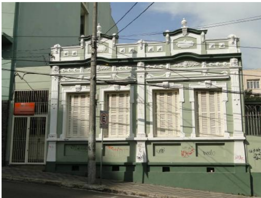
Figura 140 – Imóvel na Rua Coronel Niederauer, nº 1613
