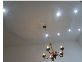
Figura 07: Forro e rebaixamento e lustre (08)
