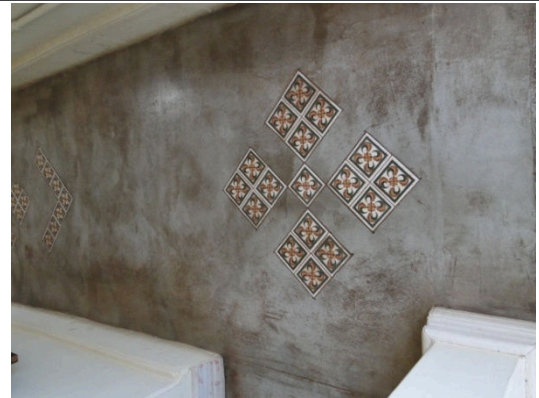
Figura 04: Piso de cimento queimado e ladrilho (cômodo 19)
