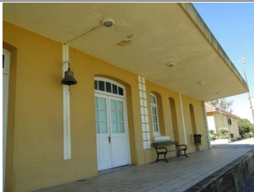
Figura 12: Vista da antiga plataforma de embarque
