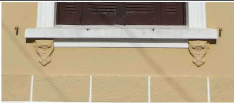
Figura 11: Detalhe do consolo abaixo da abertura
