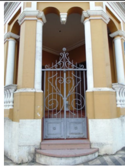
Figura 06: Portão metálico de acesso
