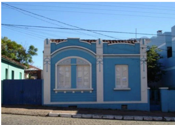
Figura 11 – Edificação na Rua Barão do Rio Branco, nº 533
