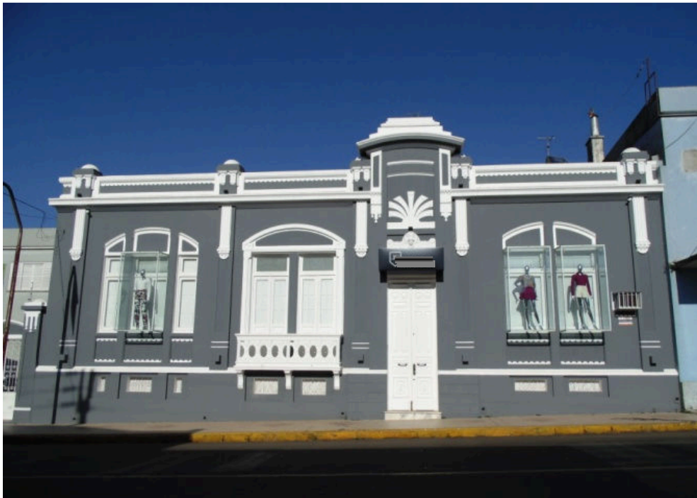
Figura 44 – Edificação 04 - Avenida Júlio de Castilhos, construída em 1923
