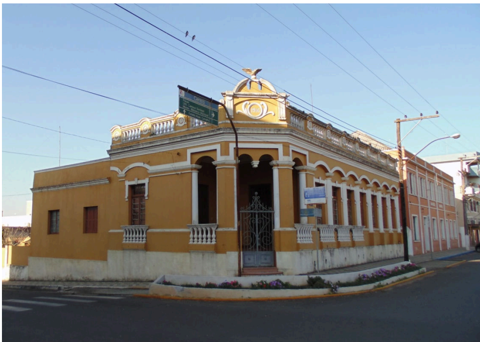
Figura 42 – Edificação 02 - Rua Pinheiro Machado, construída em 1916
