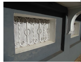
Figura 08: Gateiras na fachada
