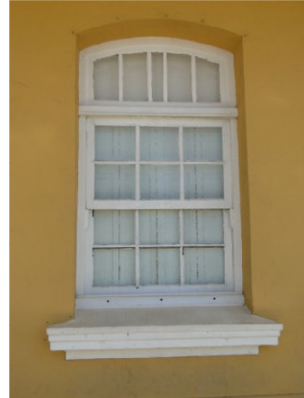
Figura 11: Janela tipo guilhotina com bandeira fixa
