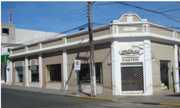
Figura 29 – Edificação Avenida Getúlio Vargas, n° 1793, construída em 1935
