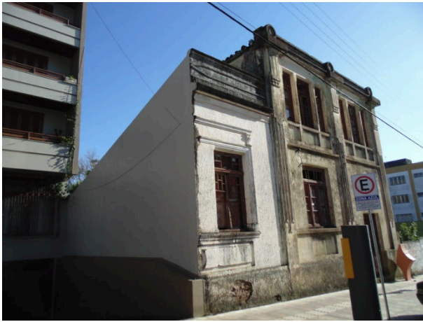
Figura 25 – Edificação Rua dos Poetas, sem número, construída em 1910
