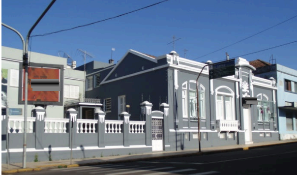
Figura 23 – Edificação Rua Sete de Setembro, n° 89, construída em 1923
