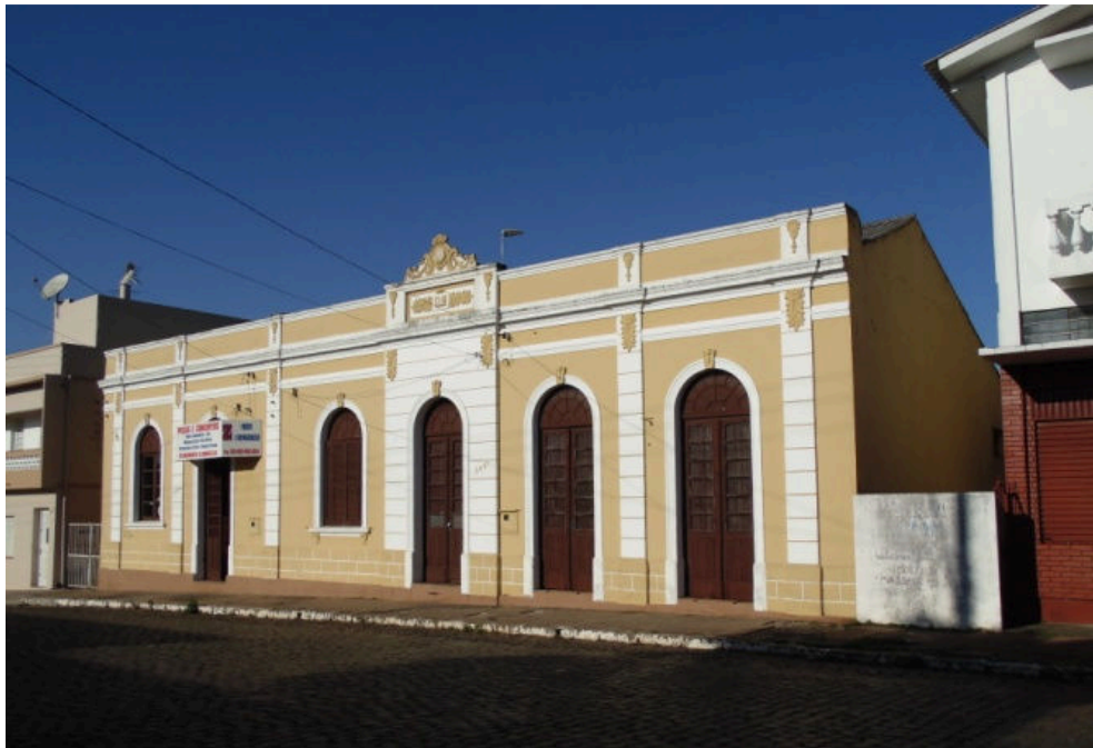
Figura 45 – Edificação 05 - Rua Tito Becon, construída em 1932
