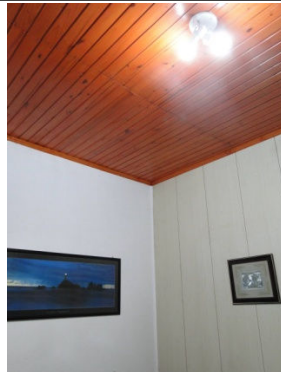
Figura 02: Forro em lambri de madeira (11)
