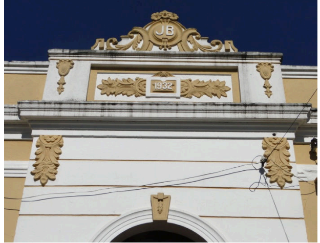
Figura 12: Detalhe do frontão com motivos florais, ornatos aplicados na argamassa.
