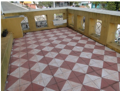
Figura 09: Piso de ladrilho hidráulico Terraço (cômodo 23)
