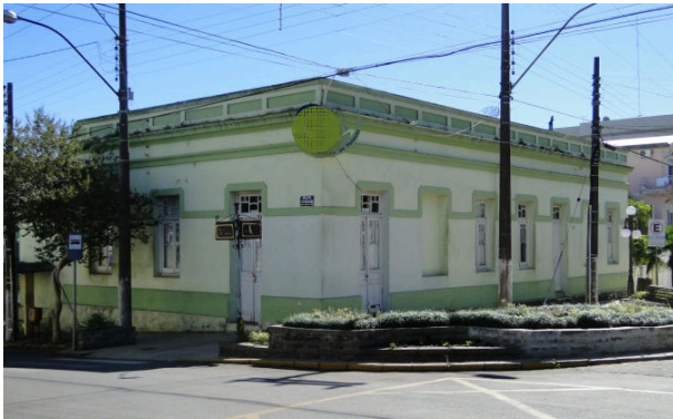
Figura 32 – Edificação Rua dos Poetas, nº 871, construída em 1920
