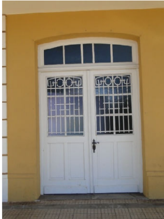
Figura 10: Porta em madeira com bandeira fixa
