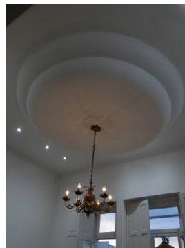
Figura 02: Forro e rebaixamento (cômodo 05)
