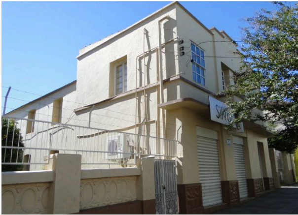
Figura 35 – Edificação Avenida Getúlio Vargas, n° 1868, construída em 1898
