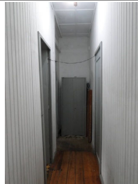
Figura 03: Paredes em lambri e forro em chapas de compensado (9)
