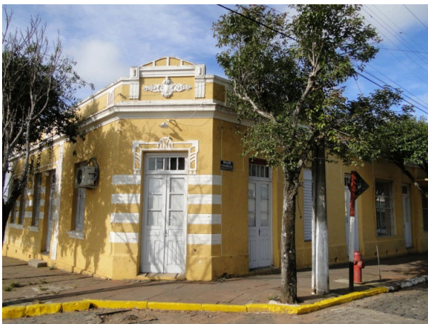
Figura 38 – Edificação Rua Tito Beccon, nº 578, construída em 1930
