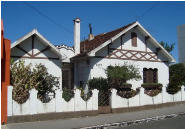
Figura 31 – Edificação Rua Benjamin Constant, nº 223, construída em 1932
