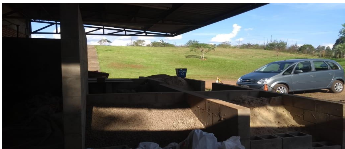
Figura 9 – Armazenamento do material fresado
