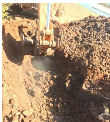
Figura 12 – Escavação do solo para instalação do sistema.
