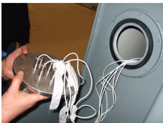
(a) Conexão das fibras no TankWall
