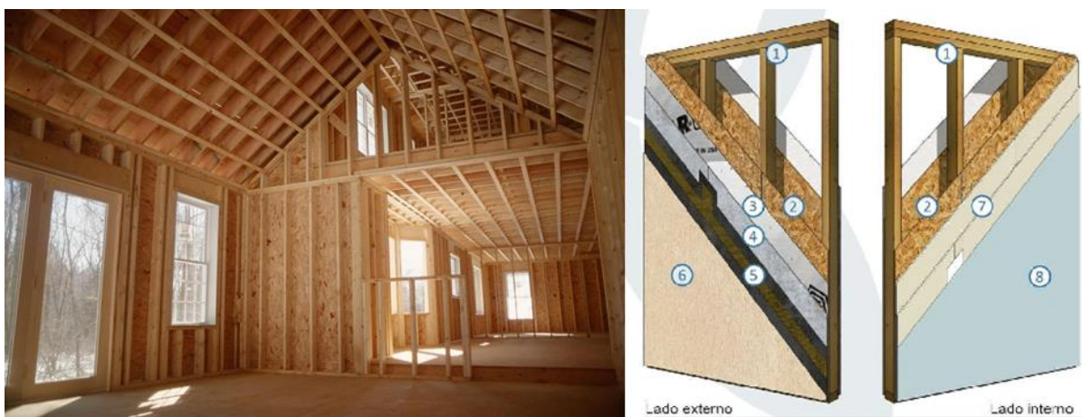
Figura 1: Composição da estrutura do sistema Wood Frame .
