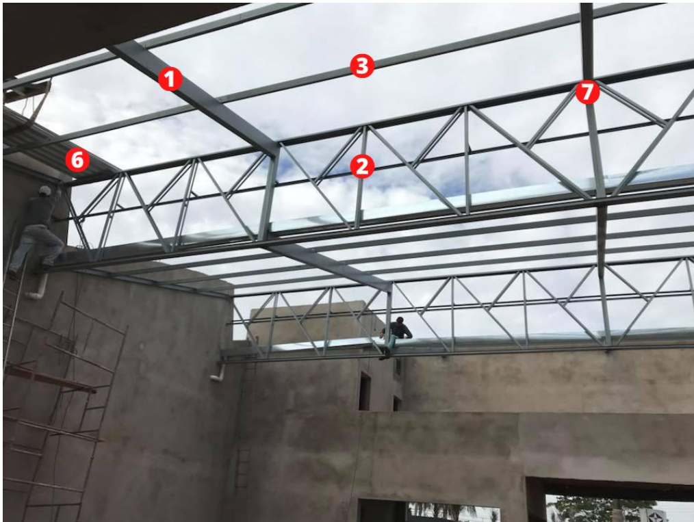
Figura 33 - Cobertura "Shed" da empresa MPM Estruturas Metálicas e seus elementos funcionais.
