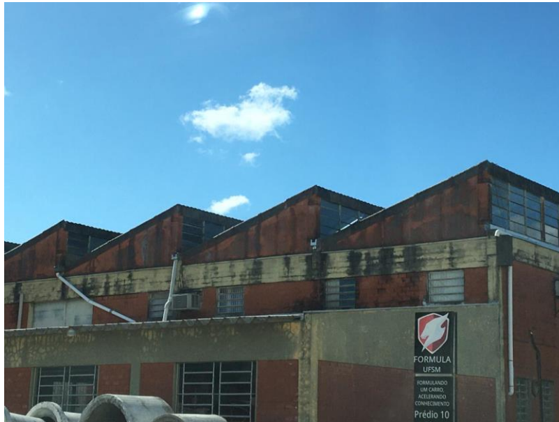
Figura 25 - Vista externa da cobertura do tipo "Shed" existente.
