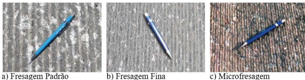
Figura 14 - Tipos de fresagem quanto a rugosidade da superfície resultante
