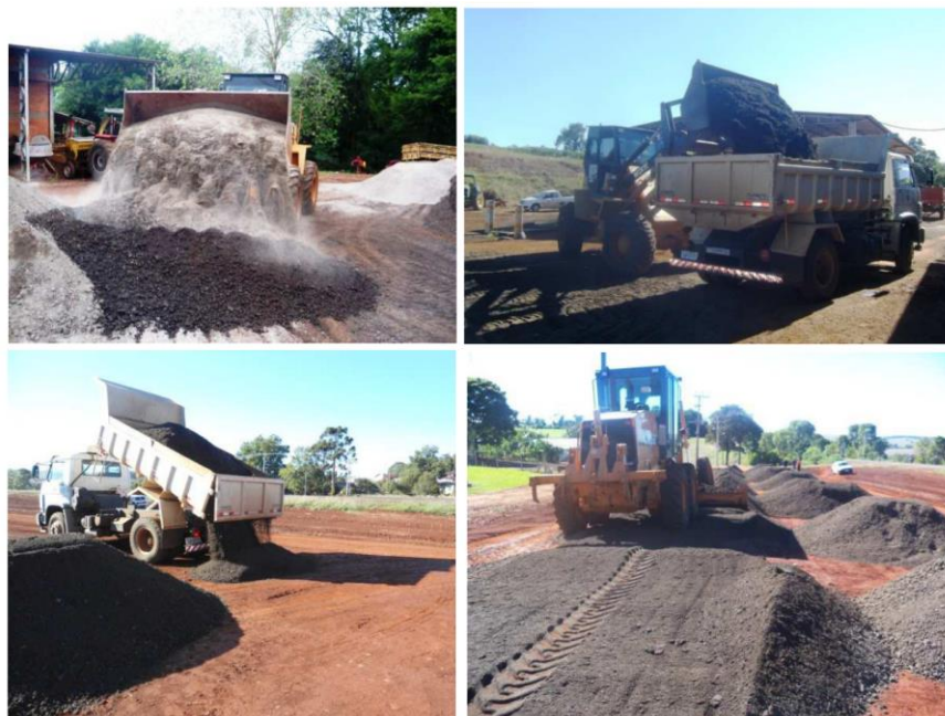
Figura 20 - Construção de trecho experimental utilizando mistura de 70%RAP e 30% pó de pedra para reciclagem a frio in situ
