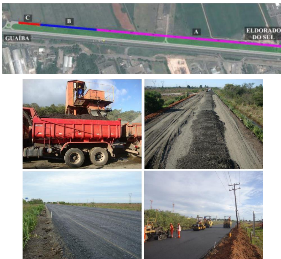
Figura 26 -Segmentos experimentais e processo construtivo
