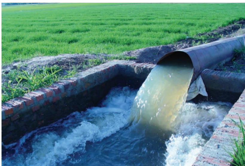
Figura 2.4 – Desague no canal de irrigação – Fim do levante em lavouras de arroz
