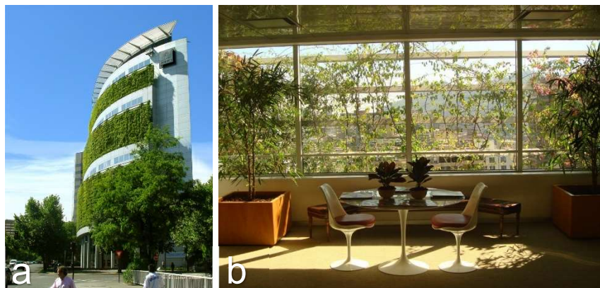
Figura 19 – Edifício Consórcio Santiago, Chile: (a) vista interna do jardim vertical; (b) elevação principal com jardim vertical
