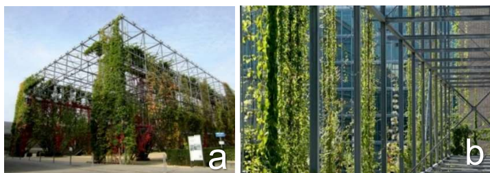
Figura 3 – MFO Park, Suíça: (a) treliças e painéis modulares; (a) cabos de aço com vegetação
