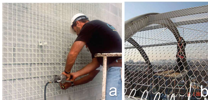
Figura 9 – Treliças modulares: (a) fixação do sistema; (b) módulos de treliças dispostos em curva
