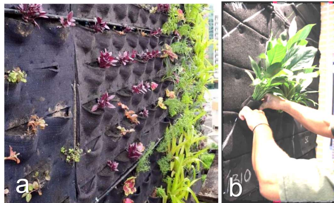
Figura 12 – Módulos de sistema contínuo de parede viva: (a) Movimento 90°; (b) Vertigarden
