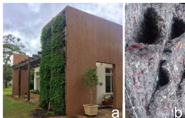
Figura 13 – Módulos de Feltro Automotivo: (a) revestimento da fachada; (b) bolsos para plantio
