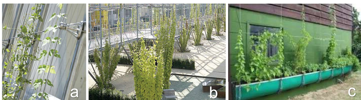
Figura 8 – Sistema de Cabos: (a) cabos em fachadas; (b) malhas de arame; (c) desenvolvido pela empresa Ecotelhado
