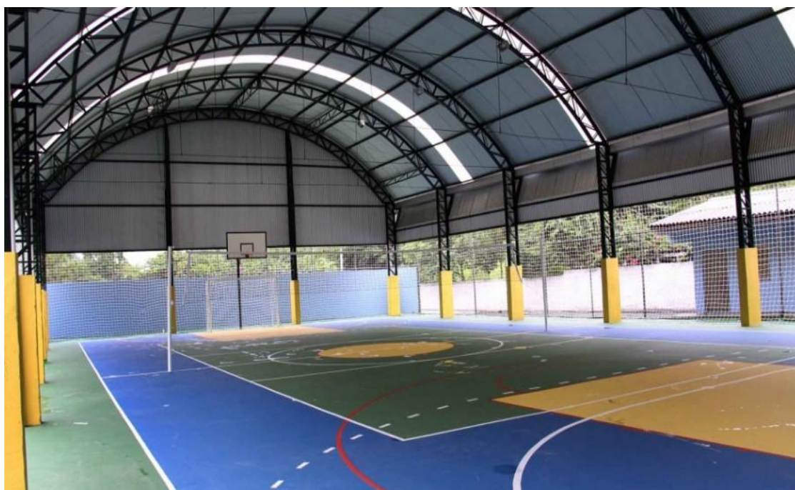
Figura 5 – Quadra poliesportiva com cobertura e sem paredes
