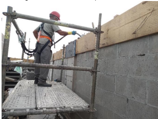
Figura 31: Uso de EPI's por colaborador
