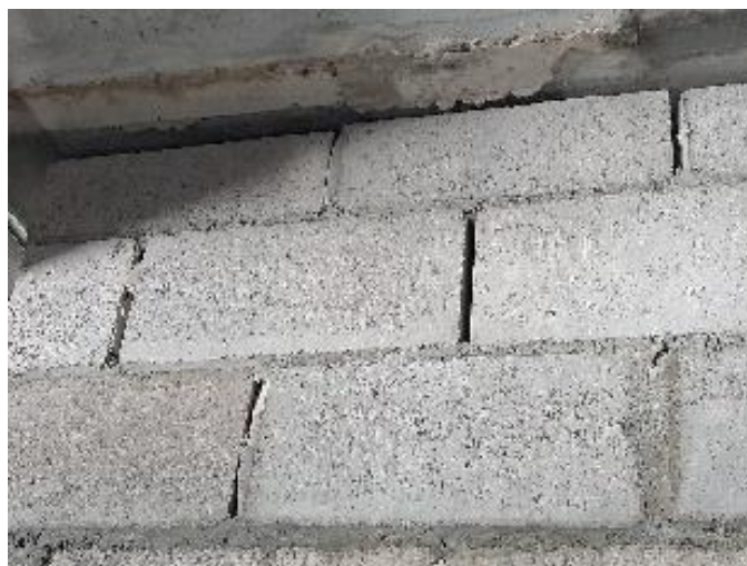
Figura 42: Alvenarias assentadas com juntas secas verticalmente
