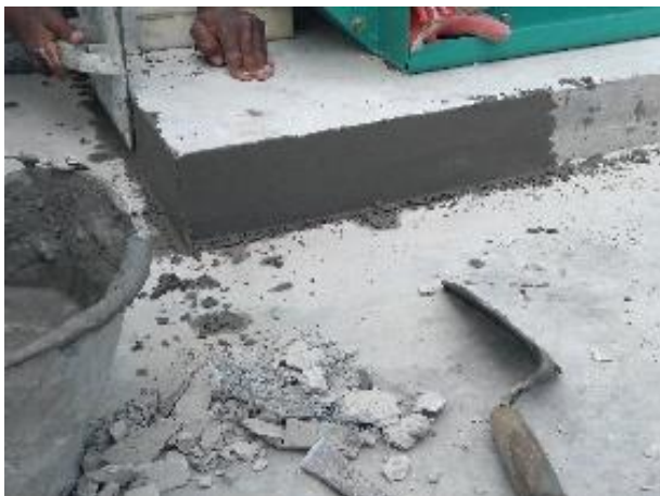
Figura 46: Fechamento de vazios em base de equipamentos
