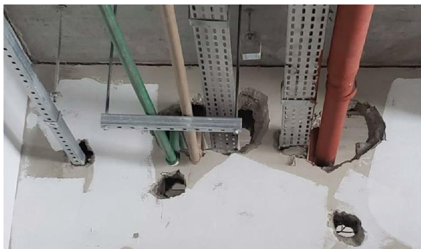
Figura 25: Abertura para passagens elétrica e hidráulica
