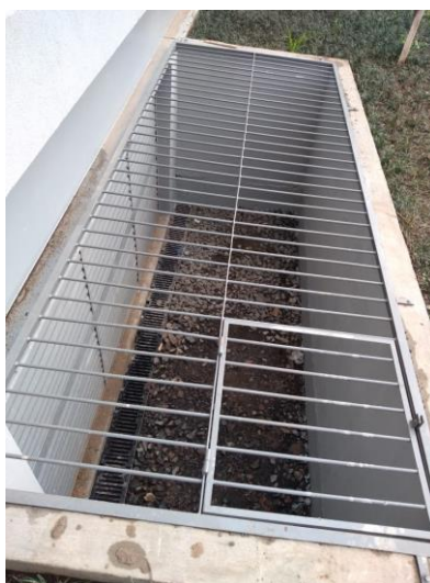
Figura 29: Execução do paisagismo – Ventilação do poço de exaustão
