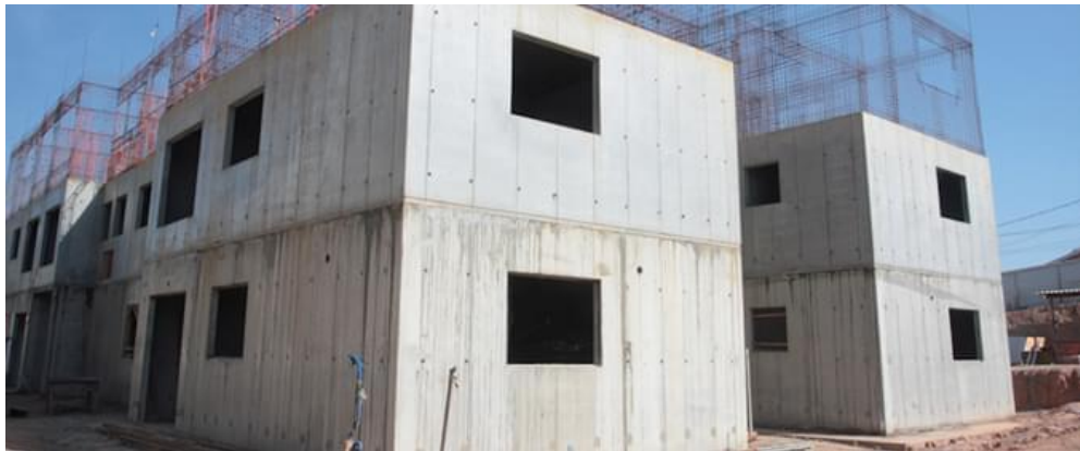
Figura 5 – Obra em paredes de concreto.
