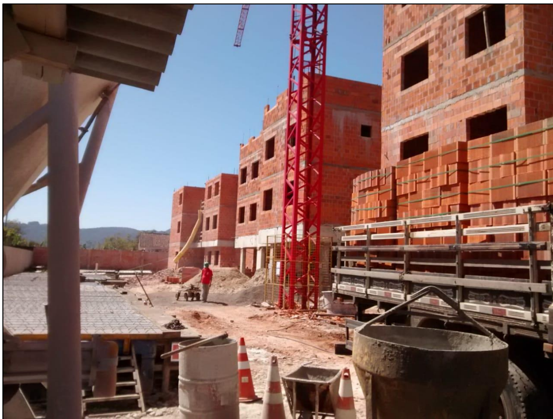
Figura 31 - Acompanhamento da obra – Bloco B. Data: 17/09/2019.
