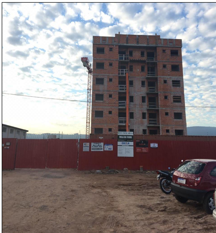
Figura 32 - Acompanhamento da obra – Bloco A. Data: 24/04/2020.
