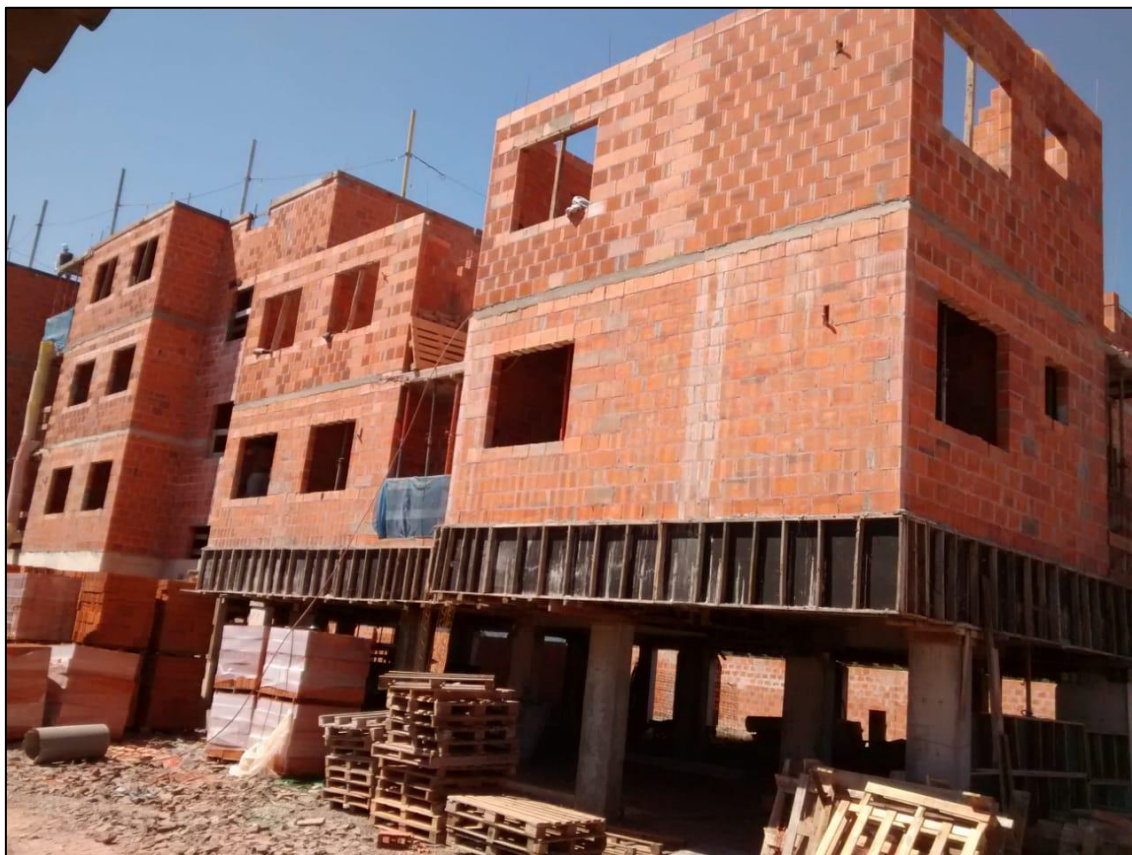
Figura 30 - Acompanhamento da obra – Bloco A. Data: 17/09/2019.
