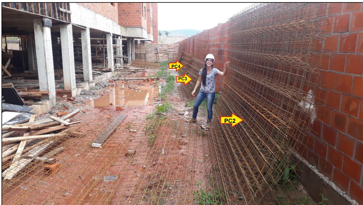
Figura 22 - Armaduras apoiadas no muro.
