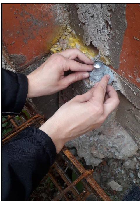
Figura 10 - Fixação do ponto de controle na estrutura do muro.
