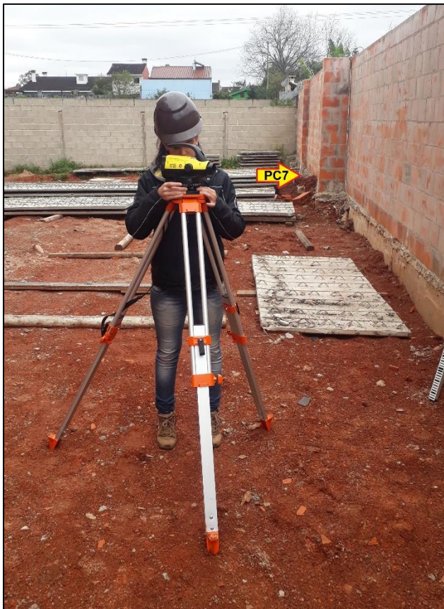
Figura 24 - Depósito de lajes pré-moldadas próximas ao muro (ponto PC7).
