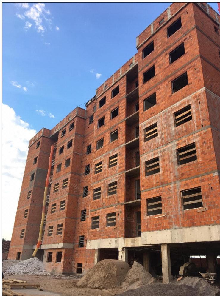
Figura 33 - Acompanhamento da obra – Bloco B. Data: 24/04/2020.
