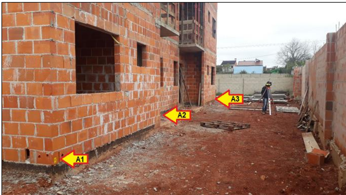
Figura 29 - Localização do pontos de nível na alvenaria – Bloco B.
