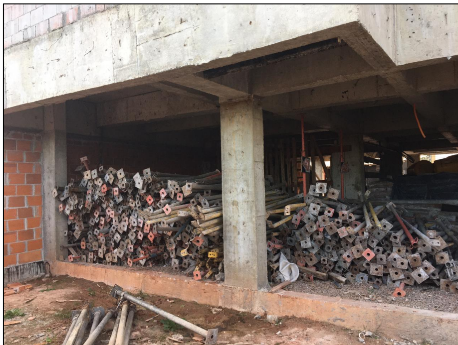
Figura 18 - Depósito de escoras metálicas no canteiro de obras.
