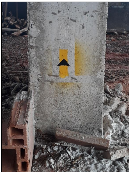
Figura 12 - Marcação do ponto de nível no pilar.
