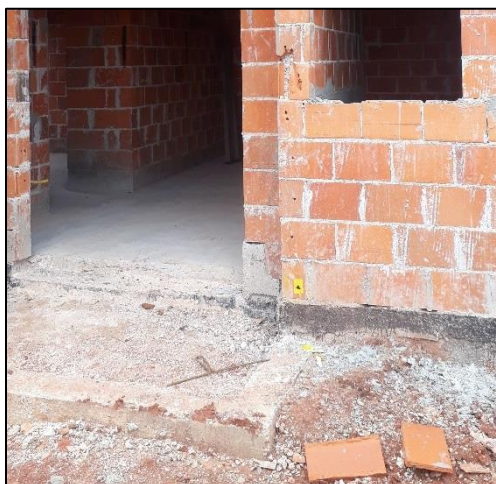
Figura 13 - Marcação do ponto de nível na alvenaria.
