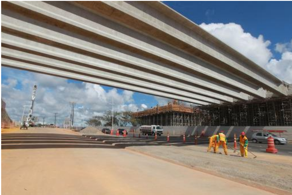
Figura 2 – Ponte sem transversinas intermediárias.
