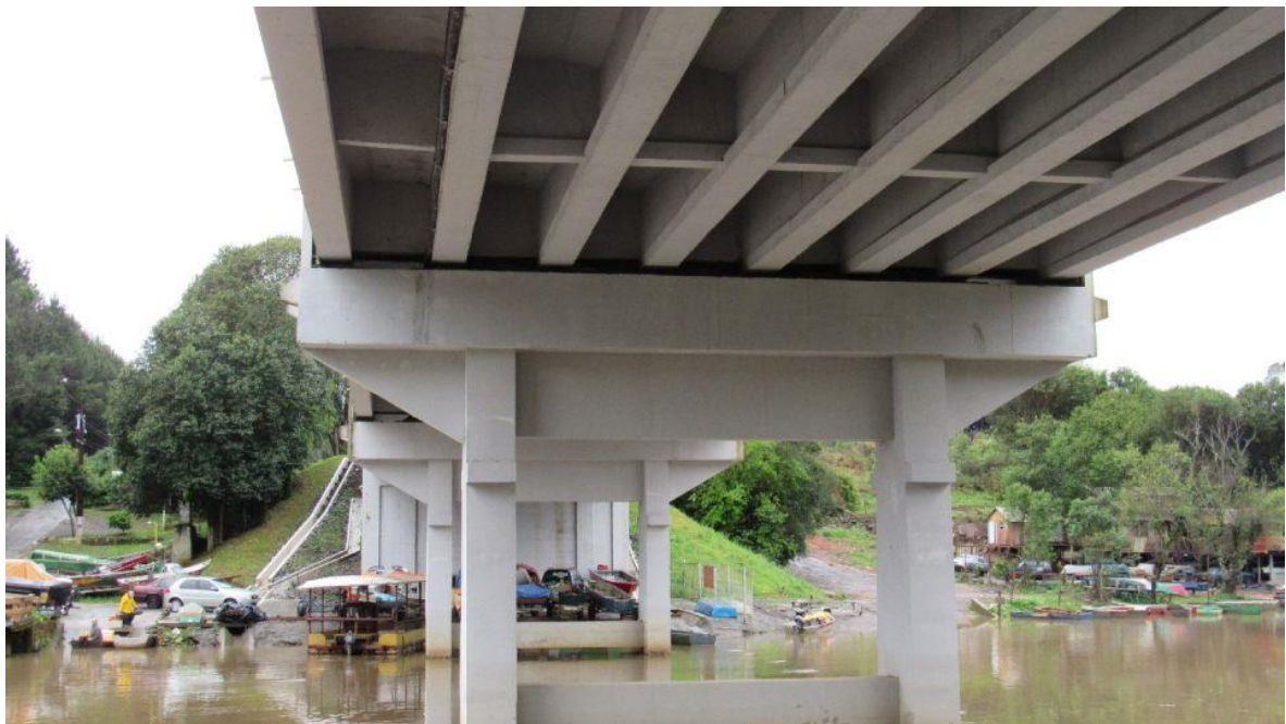
Figura 1 – Ponte com transversinas intermediárias.
