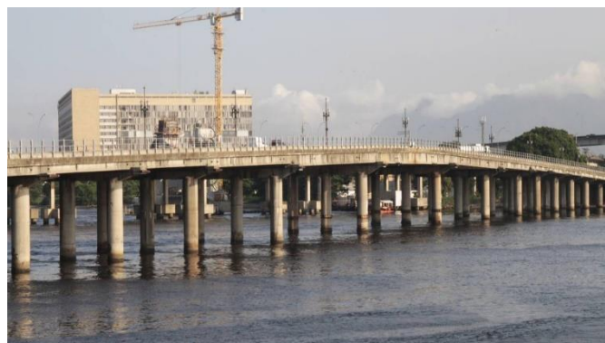
Figura 3 – Ponte do Galeão-Rio
