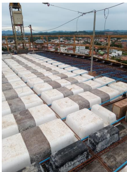
Figura 9 – Laje nervurada protendida pós-tracionada
