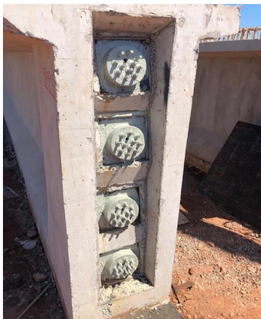
Figura 7 – Viga protendida pós-tracionada
