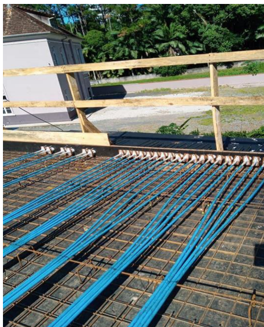
Figura 8 – Laje maciça protendida pós-tracionada
