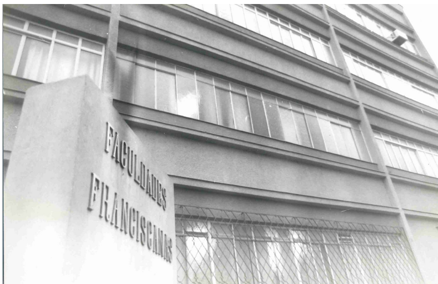
Figura 74 – Prédio acadêmico da FAFRA
