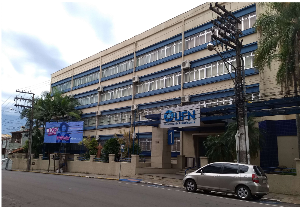
Figura 89 – Conjunto I, prédio 1 da UFN
