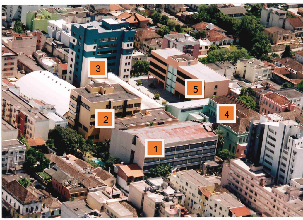
Figura 96 – Vista aérea das instalações físicas do Conjunto I da UNIFRA
