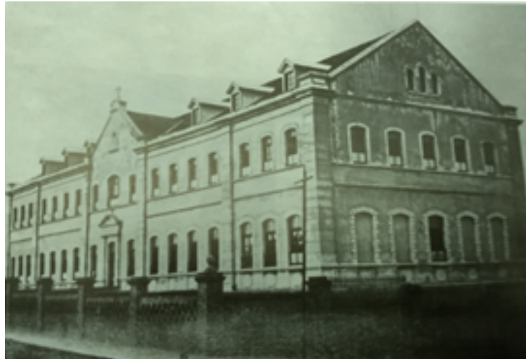
Figura 1 – Instalações do Colégio Sant'Anna
