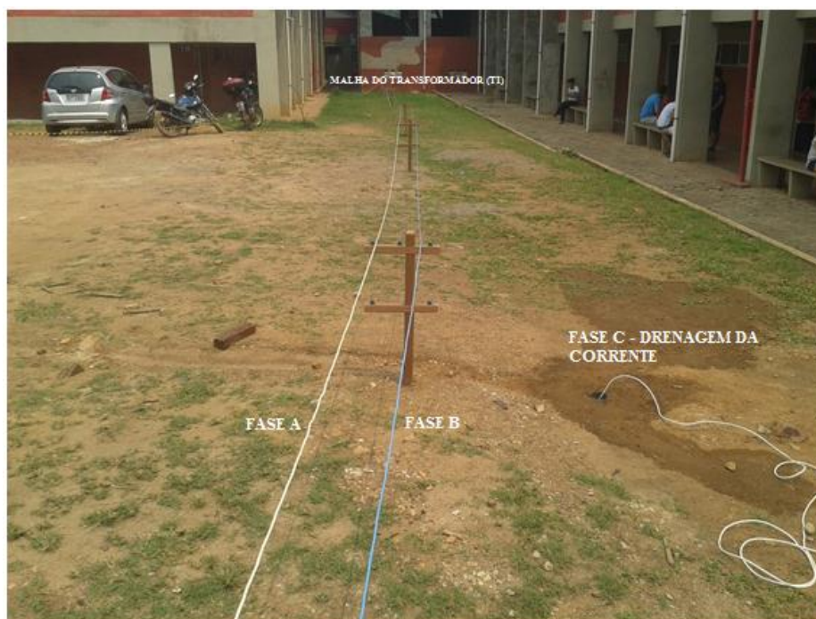
Figura 5.41 – Hegada do circuito para alimentar a carga trifásica, fase A, B e C de onde é drenada a corrente para alimentar a fase C do primário do transformador do consumidor (TC) ligado em delta. Ao fundo malha de aterramento do (TI)
