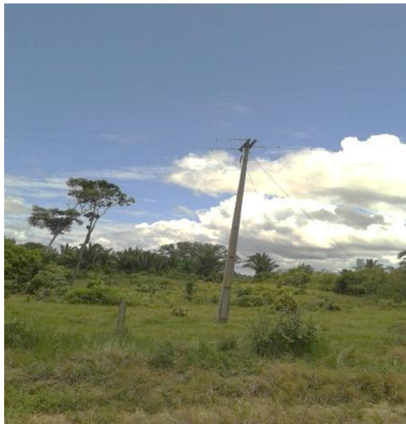
Figura 3.10 – Prosseguimento da Linha rural Eletrobrás Rondônia utilizando uma fase
