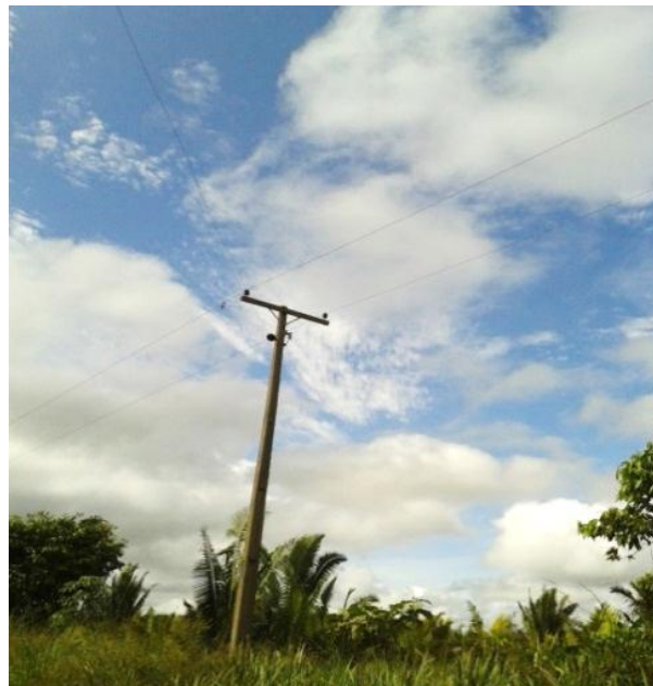
Figura 3.2 – Rede bifásica horizontal para distribuição rural
