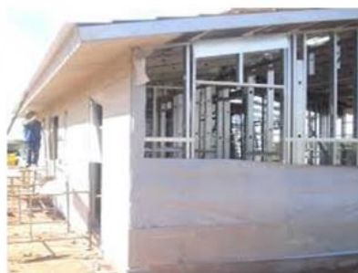
Fechamento da face externa dos quadros estruturais com placas cimentícias
