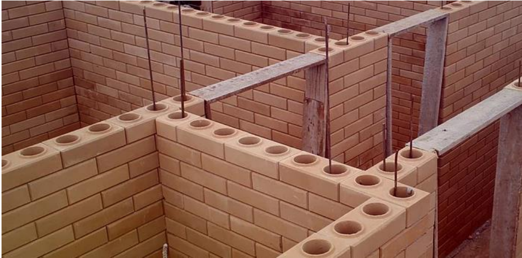
Figura 10 – Exemplo de utilização do tijolo de solo-cimento.
