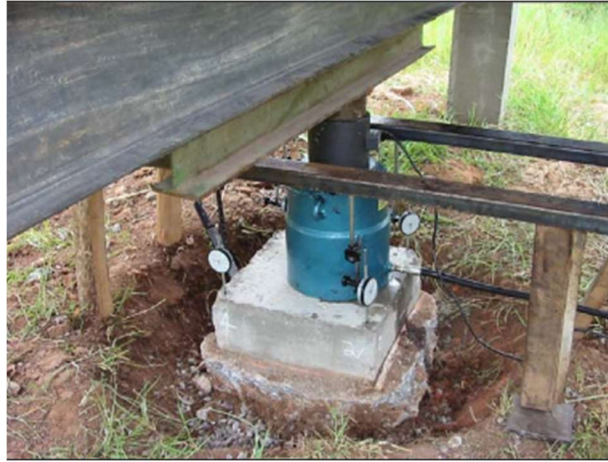
Figura 19 - Prova de carga estática sendo realizada no CEEG-UFSM.
