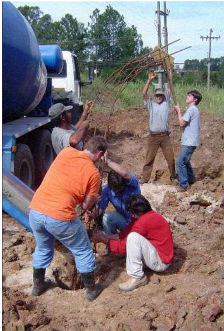
Figura 2 - Colocação de armadura em estaca escavada.
