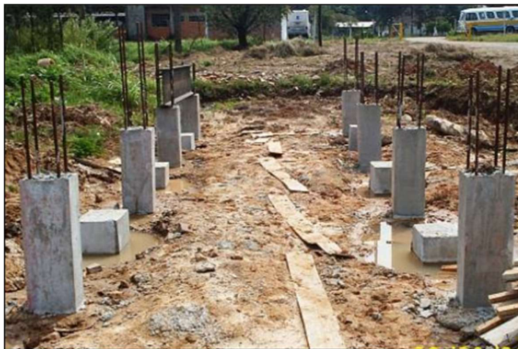
Figura 24 - Estacas executadas no CEEG-UFSM.
