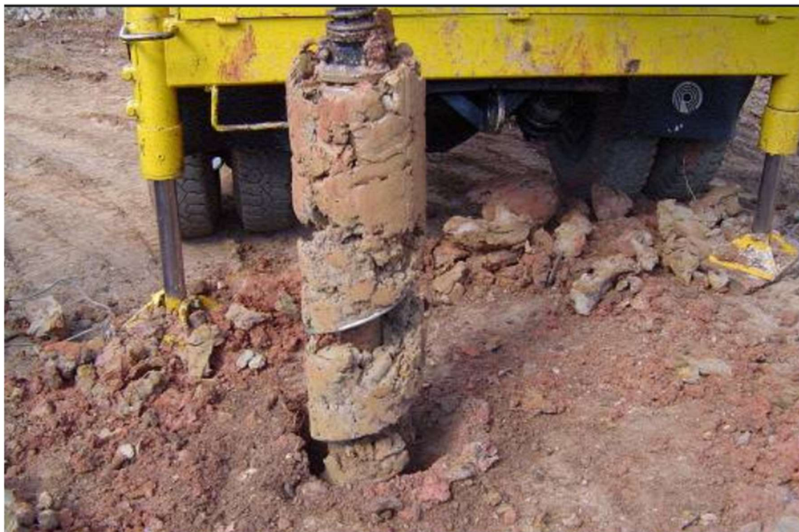
Figura 3 - Trado Helicoidal utilizado na execução de estacas.
