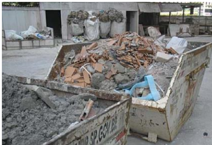
Figura 5 - Gerenciamento dos resíduos no canteiro de obras
