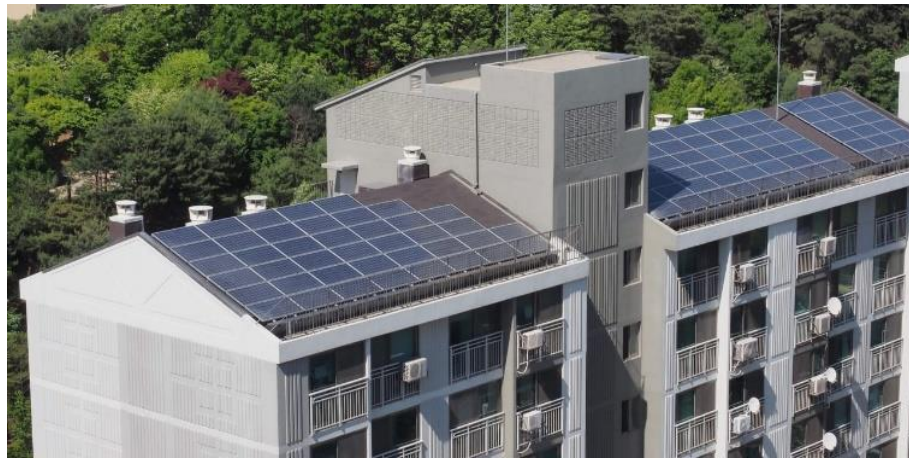
Figura 1 - Prédio com placas fotovoltaicas
