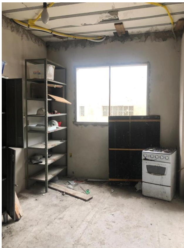
Figura 11 – Refeitório do canteiro de obras em estudo.
