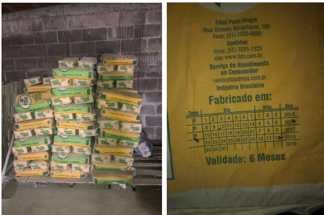
Figura 15 – Embalagens de argamassa com prazo de validade ultrapassado.
