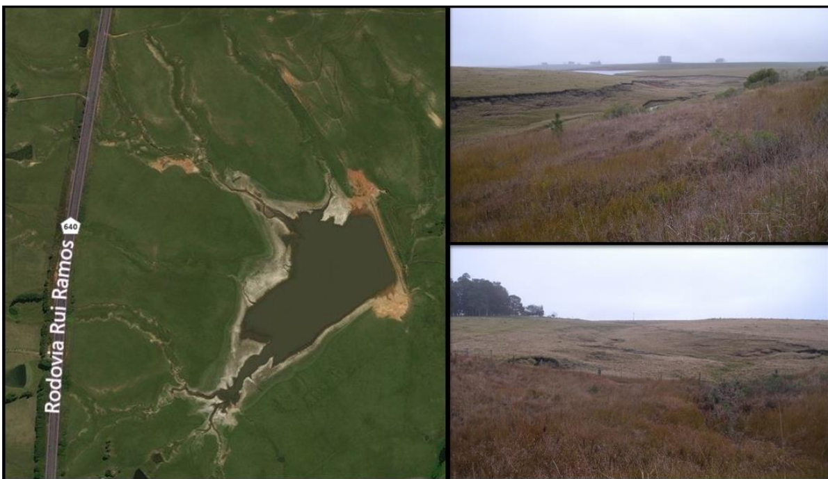
Figura 20 - Ravina próximo à rodovia de acesso ao município de Cacequi.
