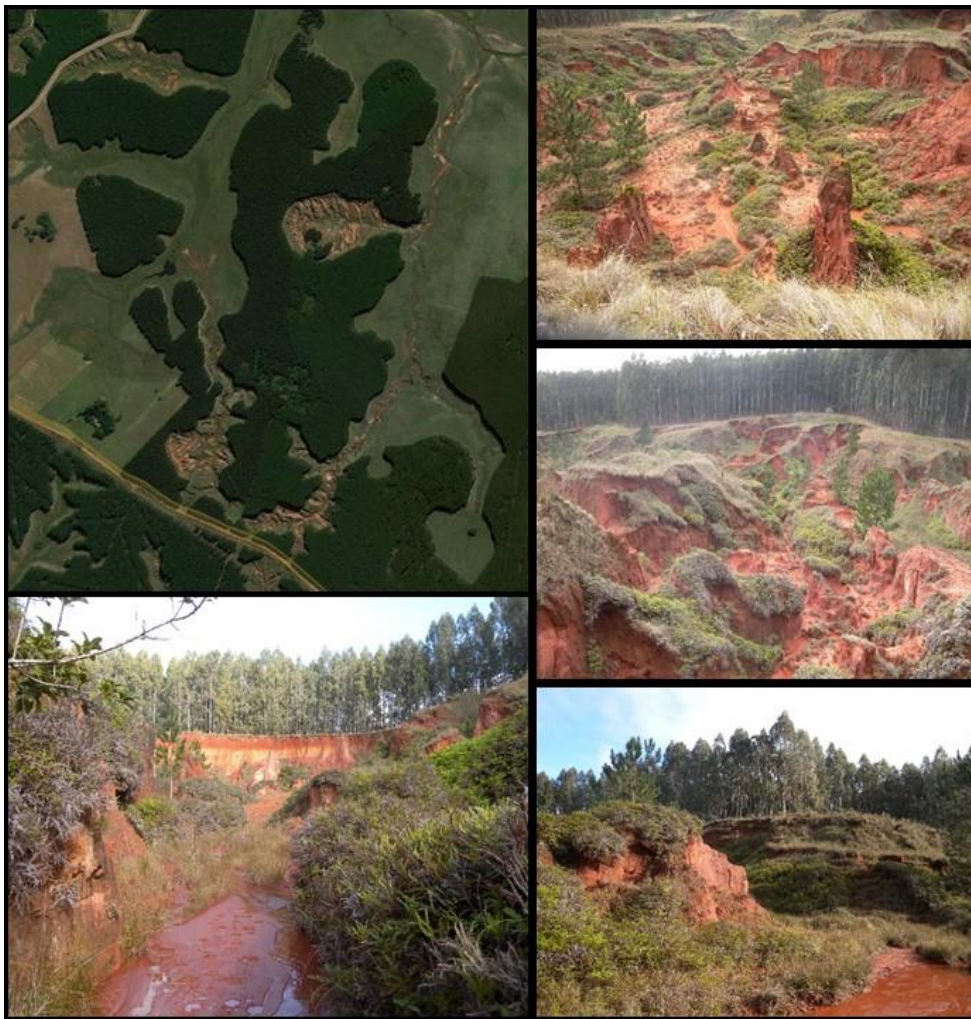
Figura 18 - Voçoroca localizada no interior do município de Cacequi.
