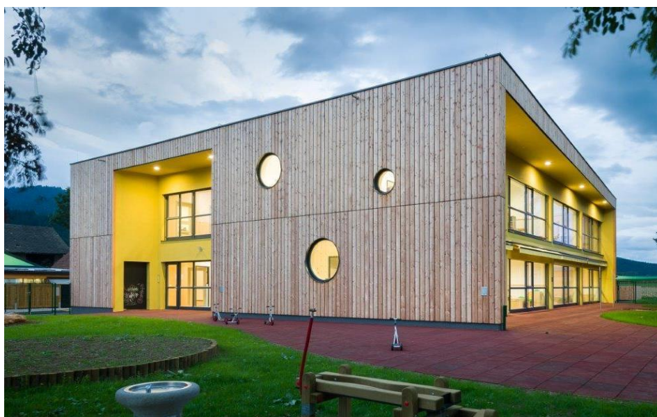
Figura 26 – Creche de tempo compartilhado Šmartno: cor como demarcação dos acessos
