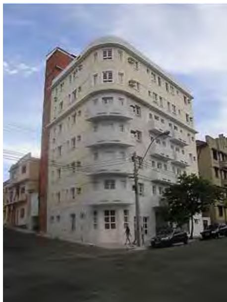
Figura 06 – Edifício Brilman (1939) – Av. Rio Branco esquina com a Rua Coronel Ernesto Becker
