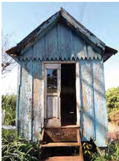
Figura 02 – Fachada principal do Capitel Mariani
