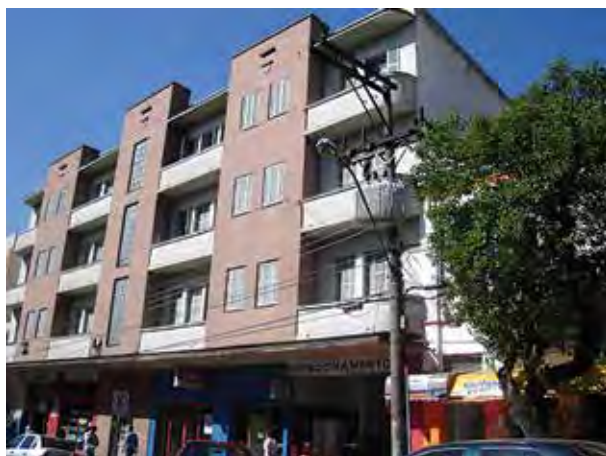
Figura 08 – Antigo Posto de Serviços Esso – Avenida Rio Branco, 842 e 854.
