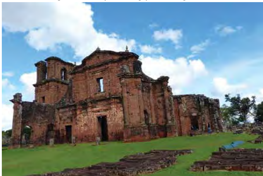
Figura 02 – Vista frontal da Igreja de São Miguel (2019)
