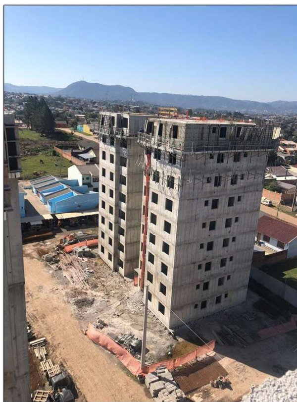
Figura 1 – Edifício executado pelo método paredes de concreto em Santa Maria – RS.
