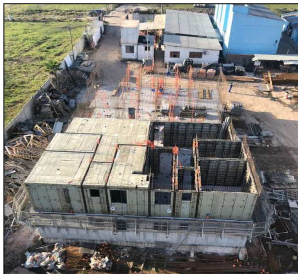
Figura 13 - Montagem das Formas Internas do Empreendimento Residencial Hera – Santa Maria – RS.
