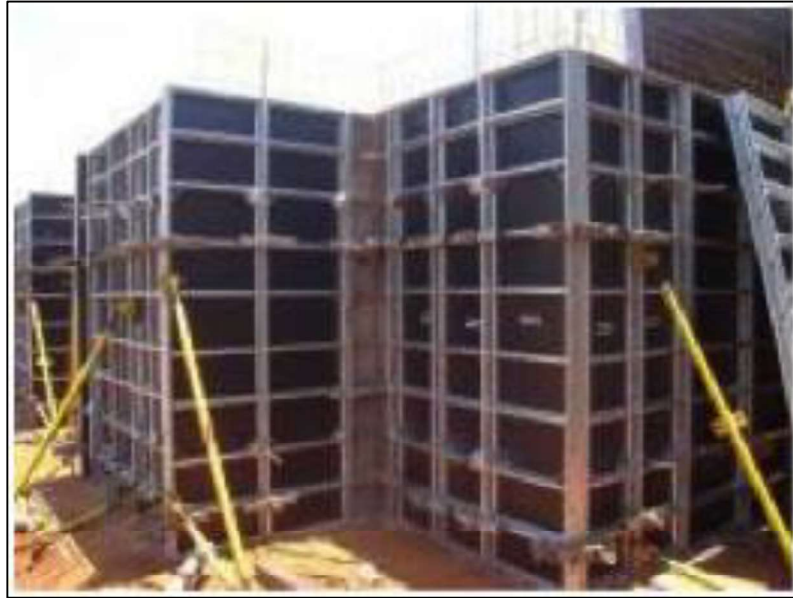
Figura 4 - Exemplificação do Sistema de Formas de Madeira Compensada com Estrutura Metálica.
