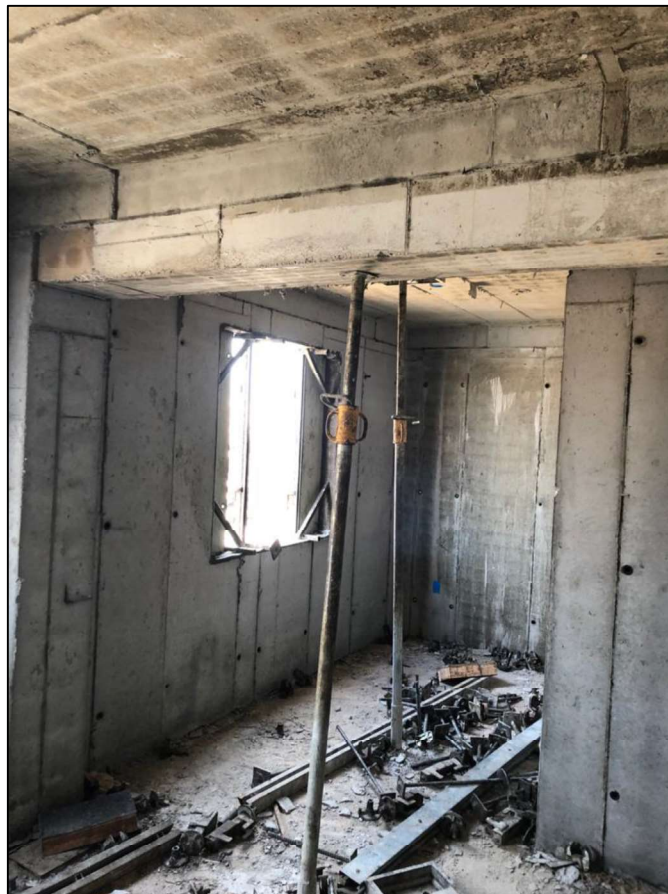
Figura 48 - Desforma da Viga do Apartamento 104D.
