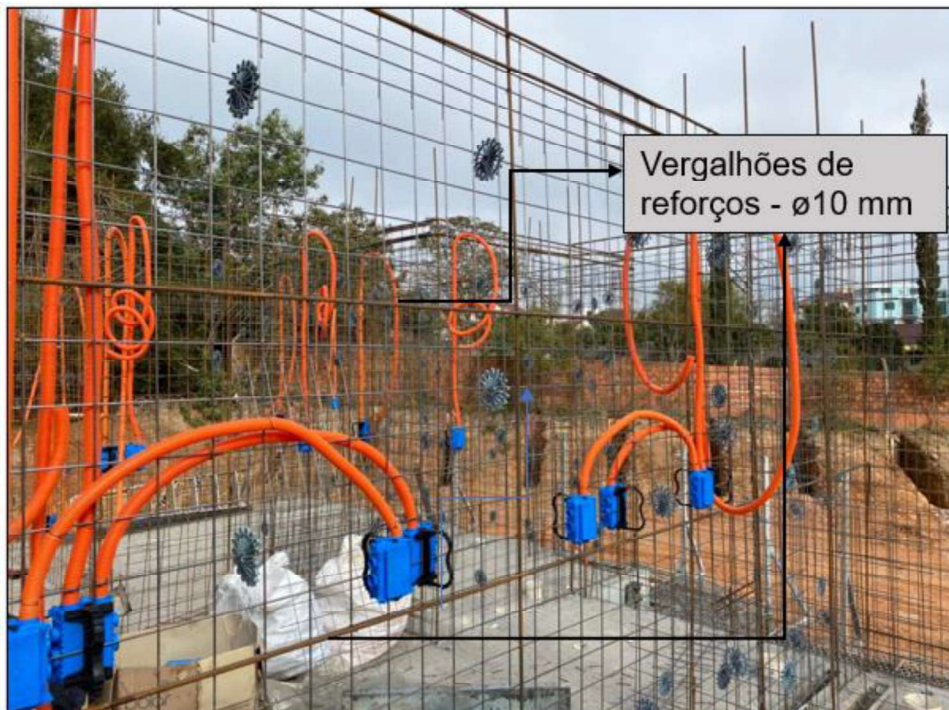
Figura 60 - Execução de Armaduras Horizontais de Reforços em uma obra em Santa Maria - RS.
