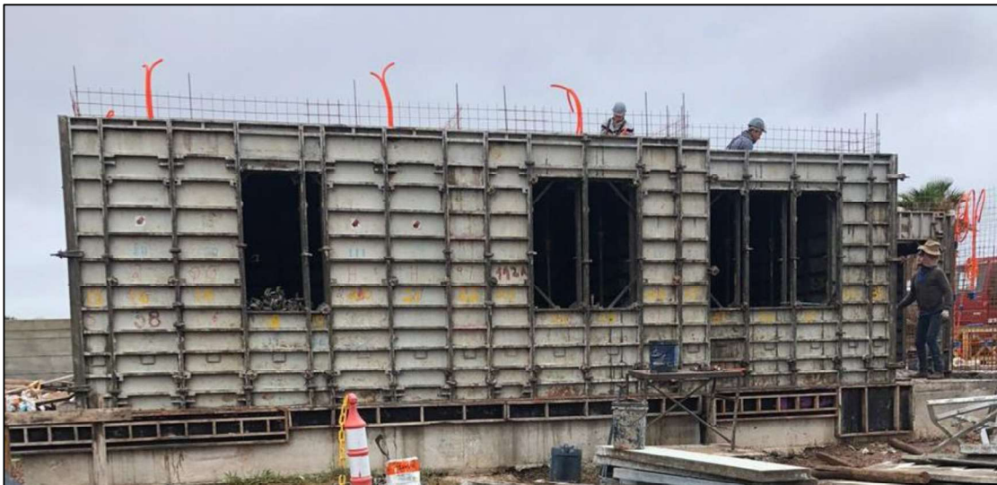
Figura 3 - Exemplificação do Sistema de Formas Metálicas em uma Obra em Santa Maria – RS.
