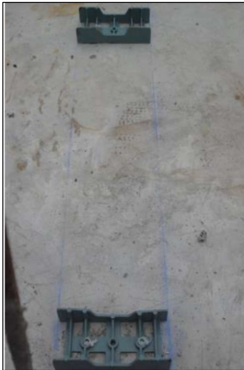
Figura 10 – Demarcação da Laje de Base para Posterior Montagem das Formas.
