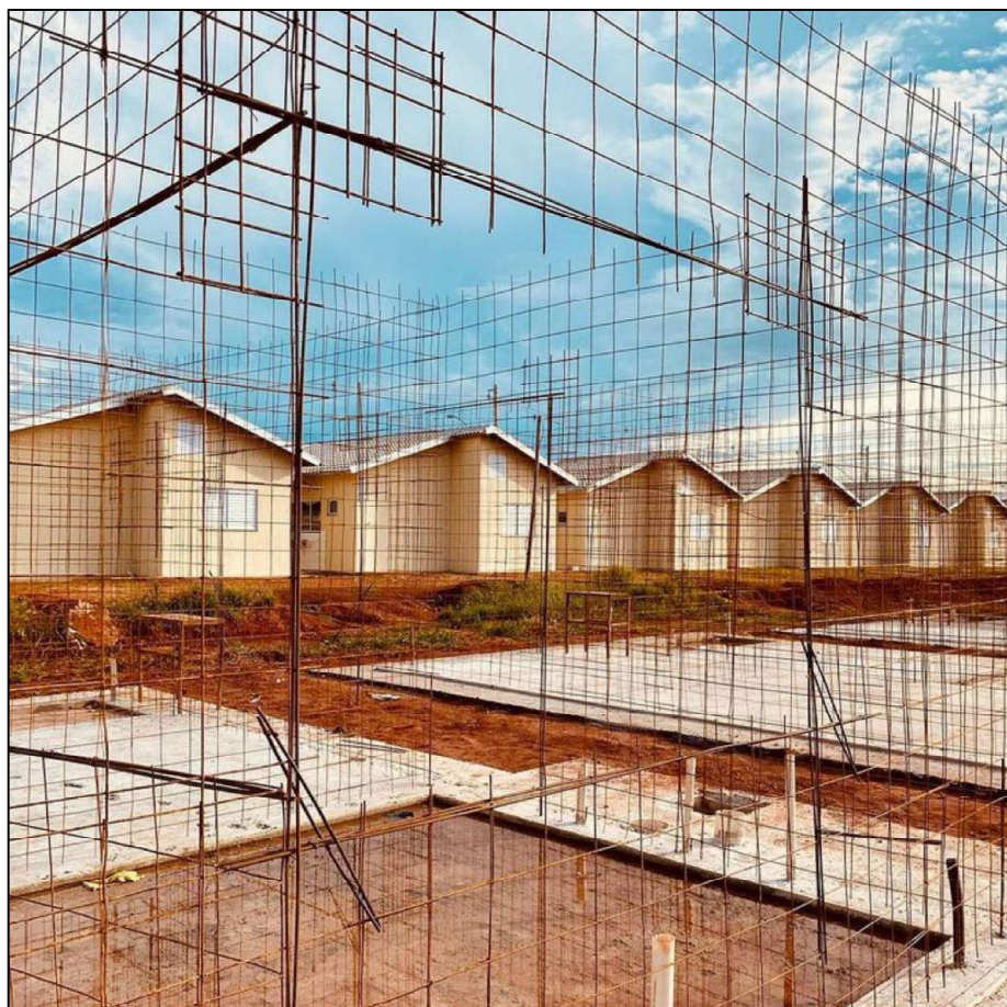
Figura 11 – Armação das Telas Soldadas juntamente com os Reforços de Vergalhões nos Cantos da Janela.
