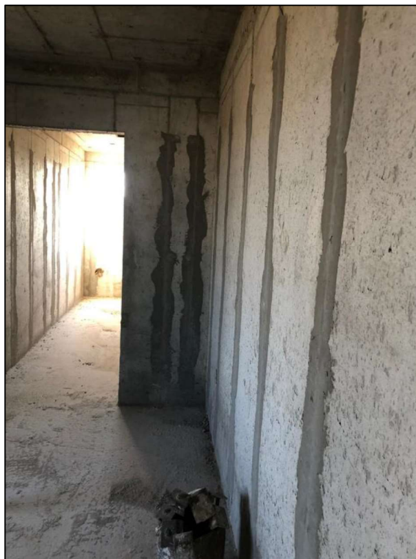
Figura 15 - Paredes Estucadas do Empreendimento Residencial Hera, Santa Maria – RS.
