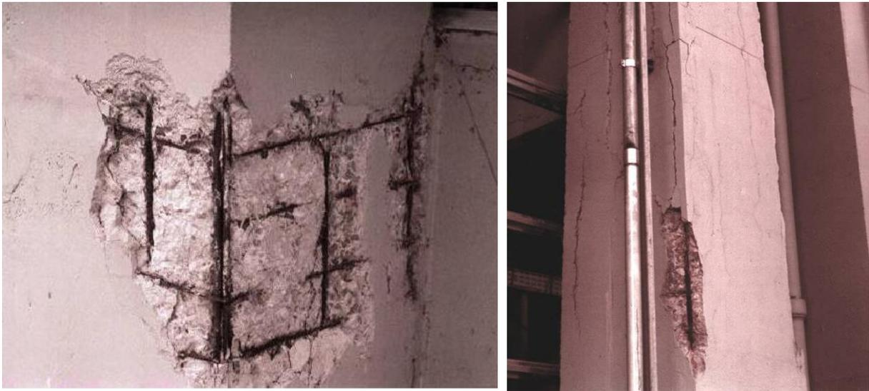
Figura 1.2 – Corrosão em estruturas executadas com aditivo com cloretos (Vagheti et al., 2002)
