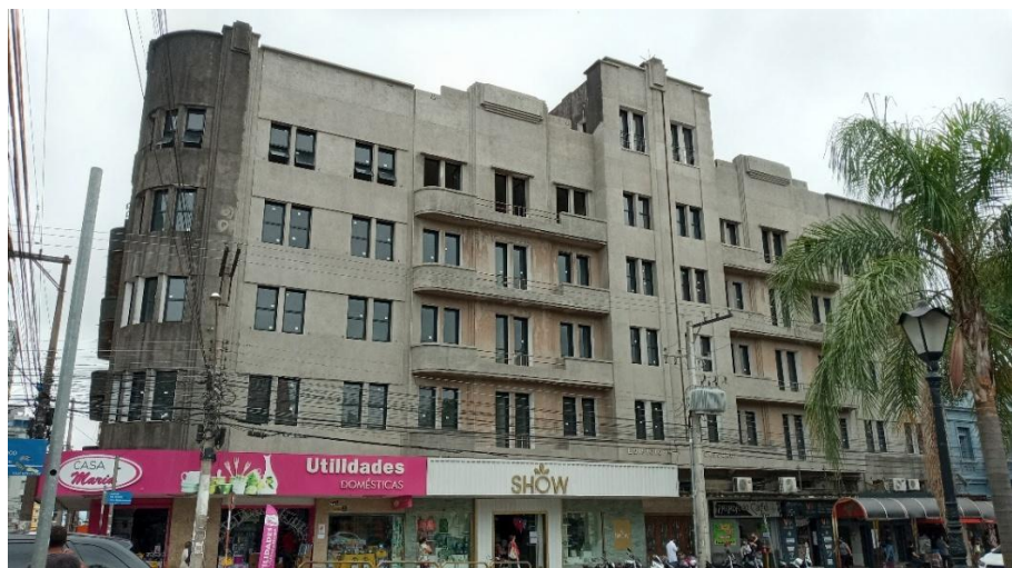
Figura 47: Edifício Cauduro – Hotel Jantzen 109
