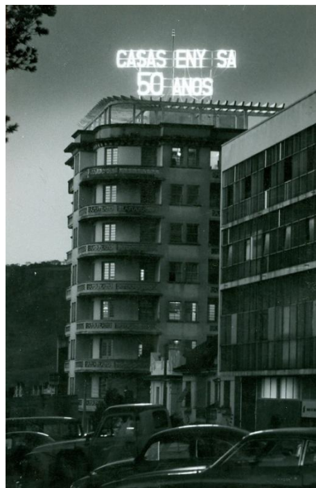
Figura 68: Edifício Mauá – Rua Silva Jardim esquina Avenida Rio Branco – Santa Maria-RS 133
