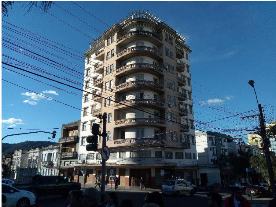
Figura 70: Edifício Mauá – Rua Silva Jardim esquina Avenida Rio Branco – Santa Maria-RS 135
