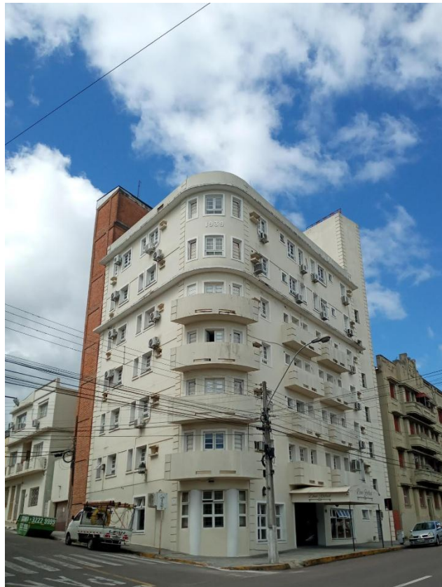
Figura 43: Edifício Brilman – Avenida Rio Branco esquina Cel. Ernesto Beck - Santa Maria/RS 103
