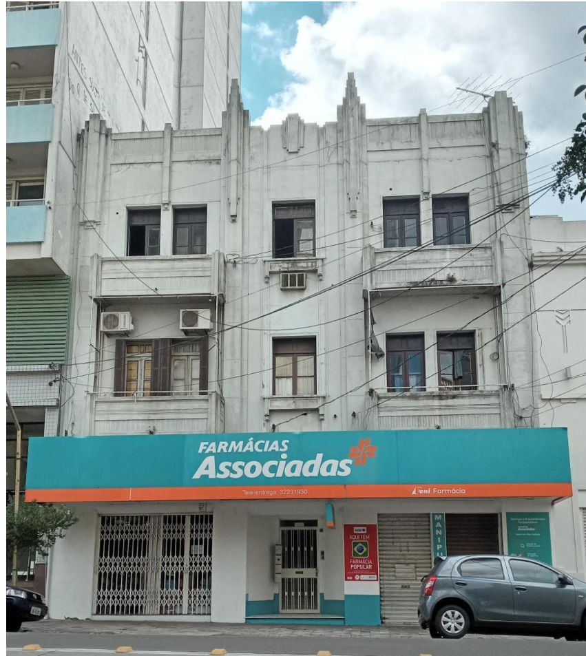
Figura 36: Rua do Acampamento, 70 - Santa Maria/RS 90
