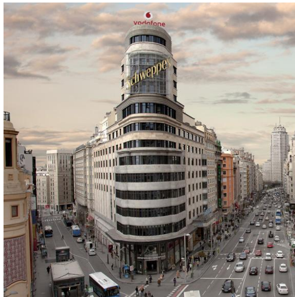
Figura 06 – Edifício Capitol ou Carrion (1931 -1933) - Madri 16
