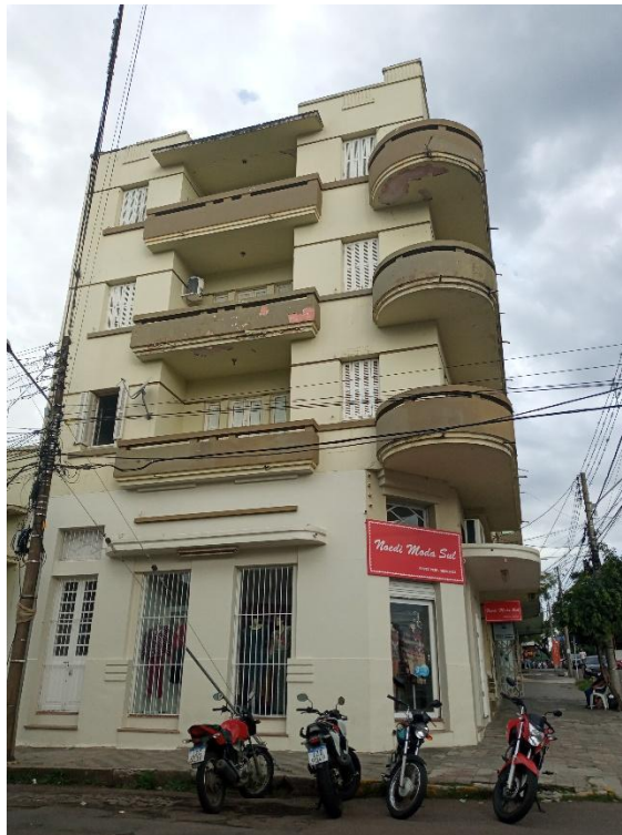
Figura 60: Edifício Ibirapuitã - Avenida Rio Branco esquina Daudt - Santa Maria-RS 121
