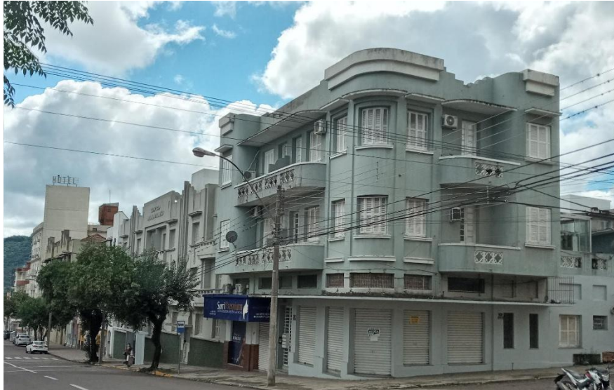
Figura 59: Edifício Santa Maria - Avenida Rio Branco esquina Daudt - Santa Maria-RS 120
