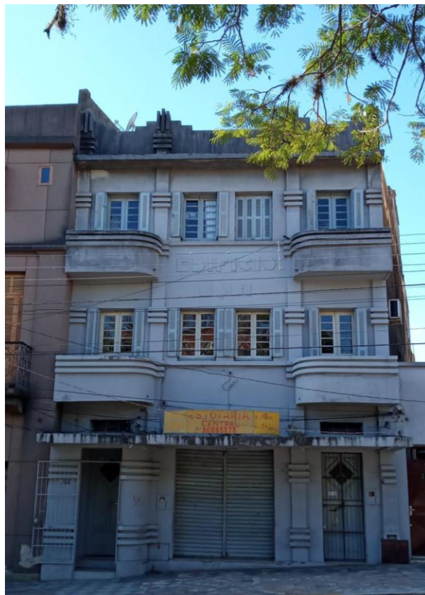
Figura 56: Edifício Mabi - Avenida Rio Branco, 134 e 138 – Santa Maria-RS 117
