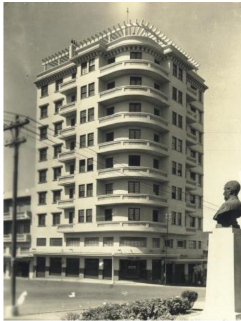
Figura 67: Edifício Mauá – Rua Silva Jardim esquina Avenida Rio Branco – Santa Maria-RS 132
