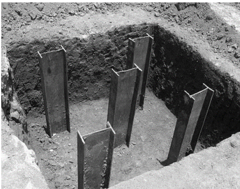
Figura 3 - Estacas metálicas cravadas
