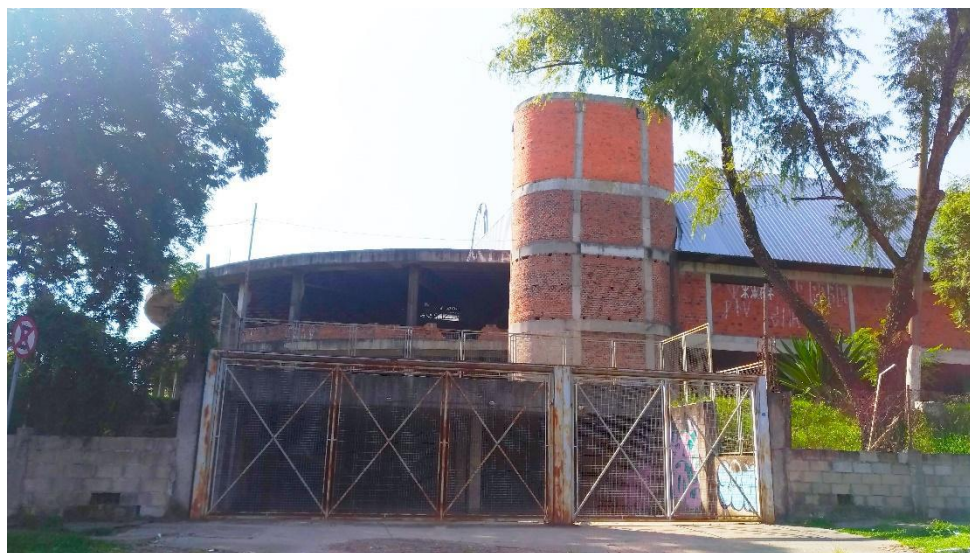
Figura 37 – Perspectiva externa do CEM - SM acesso subsolo
