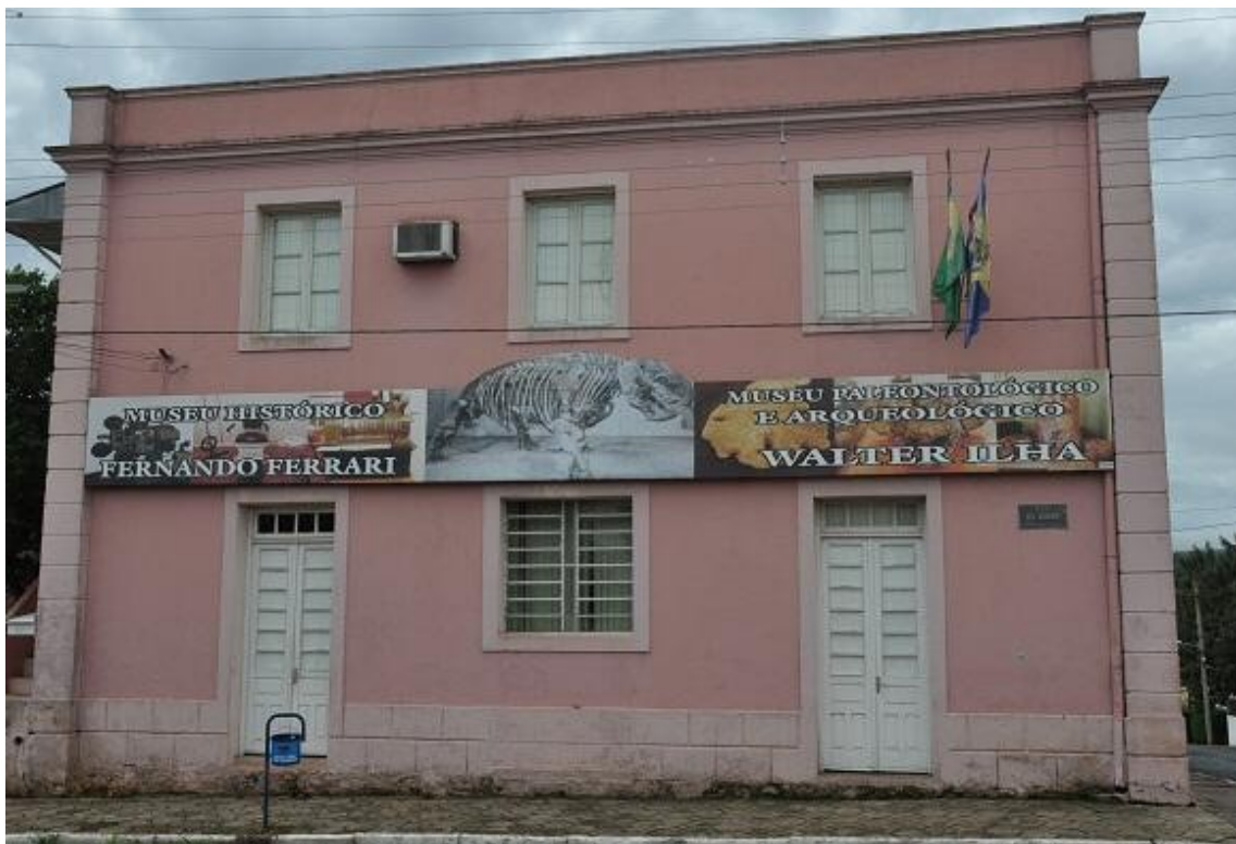
Figura 2 – Fachada do edifício da antiga Prefeitura Municipal, com a placa dos dois museus, no ano de 2013. Atualmente a cor do prédio é verde e está sem a placa com o nome do Museu.
