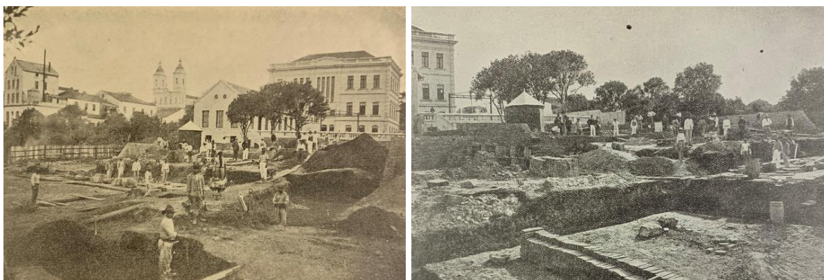
Figura 06 - Construção das Oficinas da EAO
