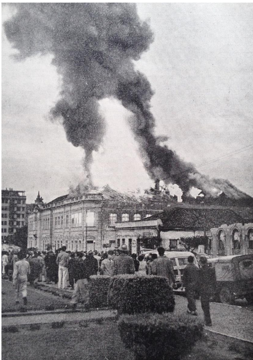
Figura 17 - Incêndio Hugo Taylor
