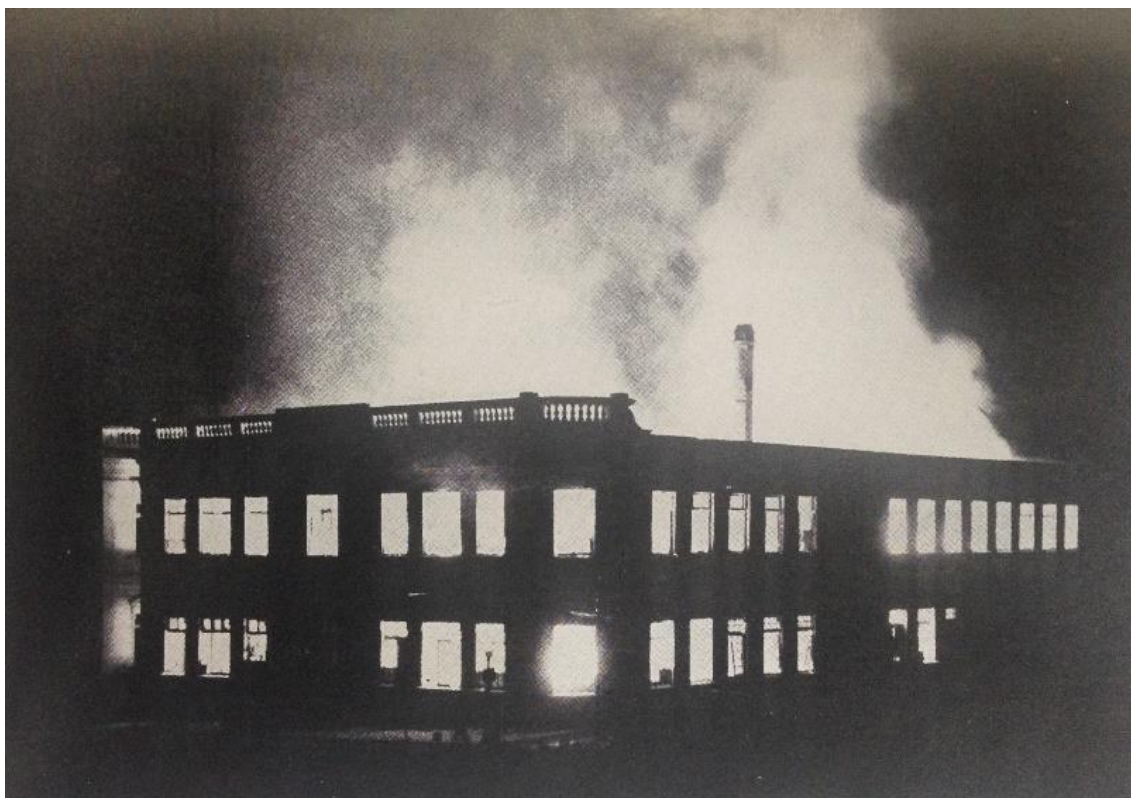
Figura 18 - Incêndio Hugo Taylor
