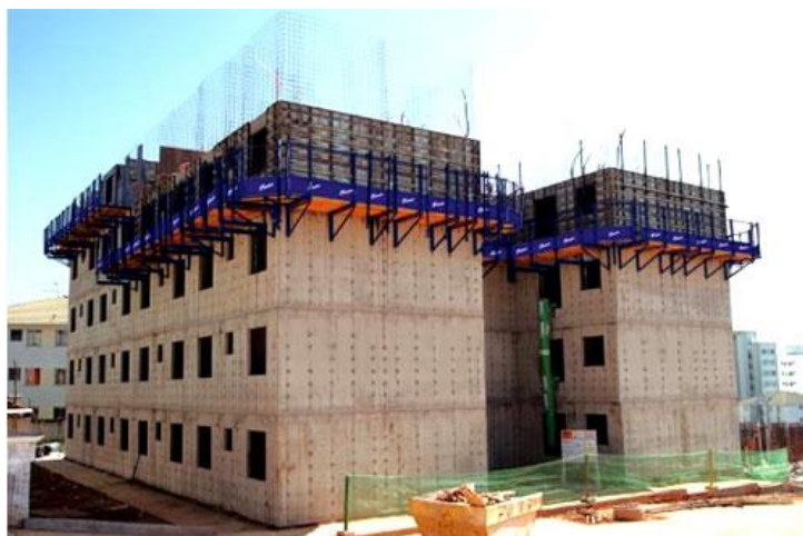
Figura 2 – Parede de concreto moldada in loco em execução
