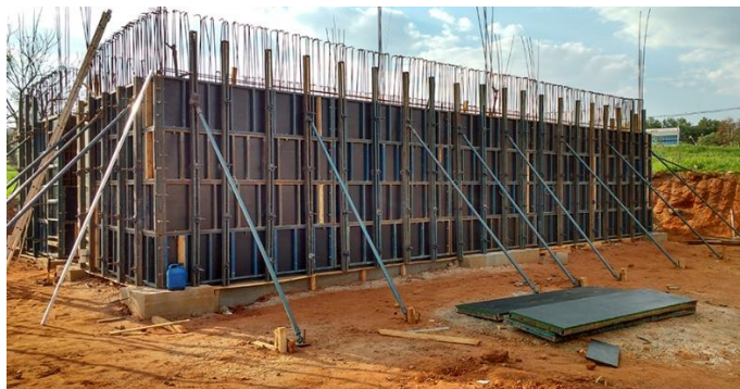
Figura 4 – Formas metálicas + compensado (quadros em alumínio ou aço e chapas de madeira compensada ou material sintético)
