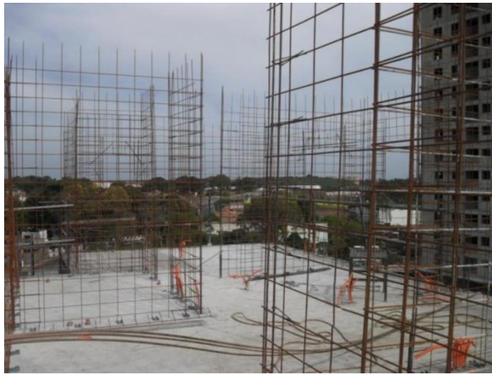
Figura 6 – Montagem das telas soldadas das paredes
