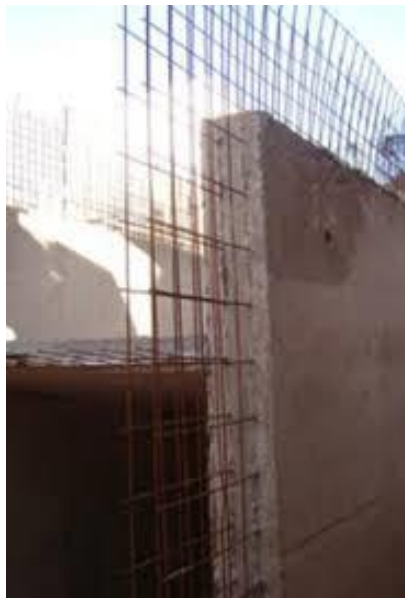
Figura 7 – Parede de concreto armado com tela dupla
