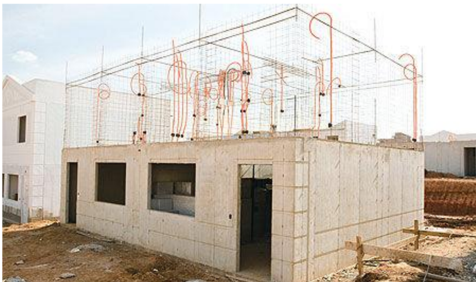
Figura 1 – Exemplo de casa assobradada executada em sistema de paredes de concreto
