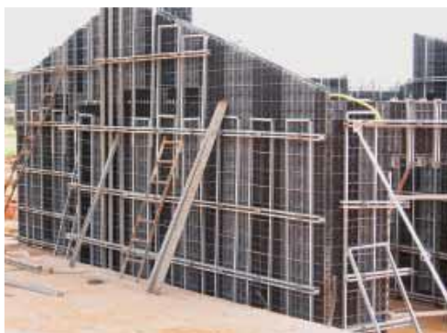
Figura 5 – Formas plásticas (quadros e chapas de plástico reciclável contraventadas por estruturas metálicas)
